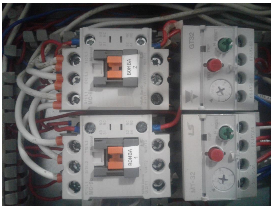
Figura 3.3. Contactores de tres polos con relés de sobrecarga para el accionamiento de las bombas centrífugas de la máquina de fertirriego.
