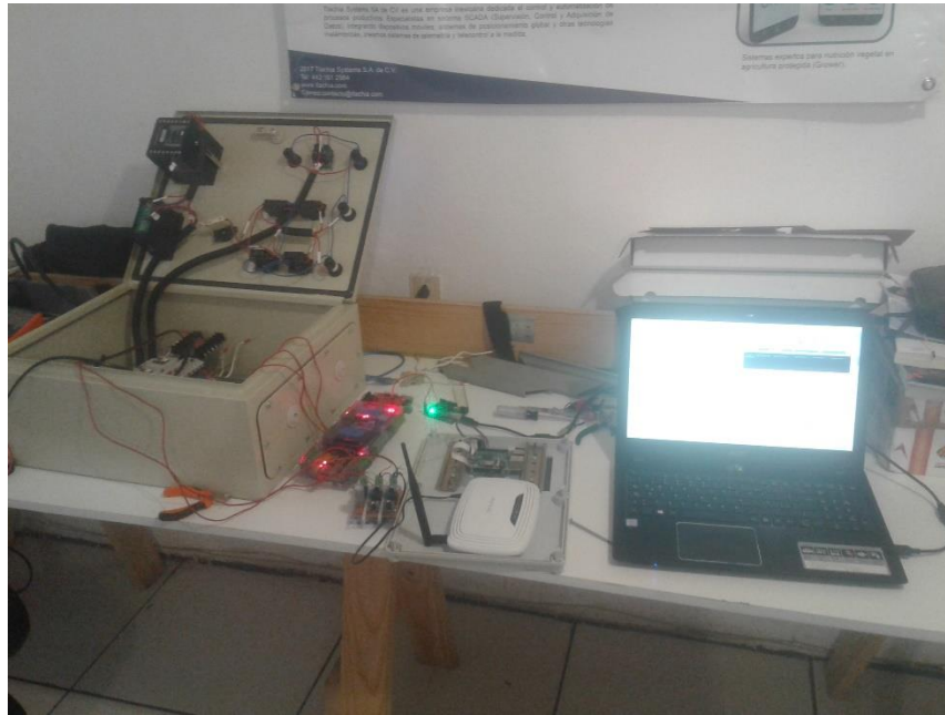
Figura 3.27. Pruebas realizadas para verificar la funcionalidad del sistema SCADA con el panel de control.
