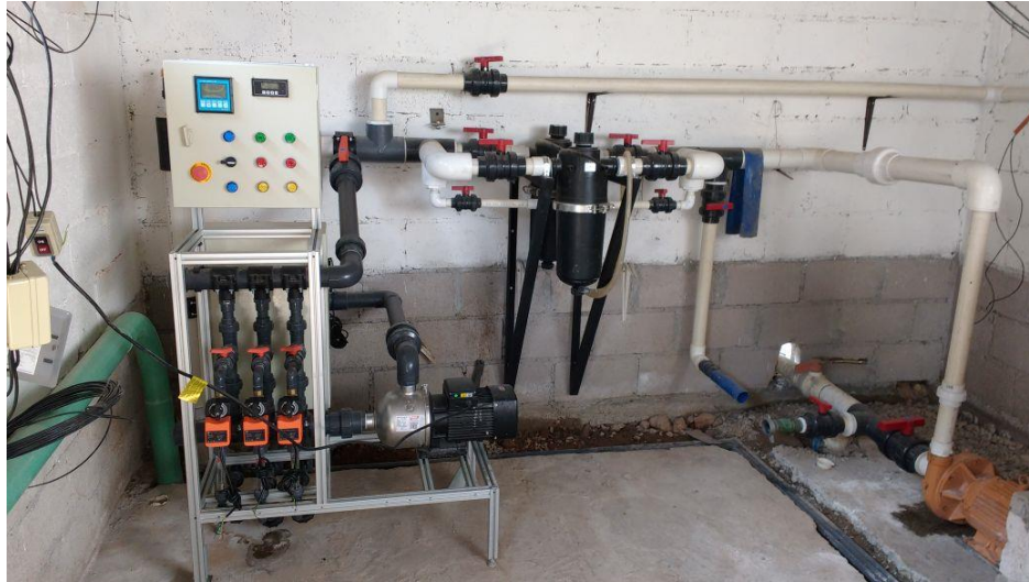
Figura 4.13. Máquina de fertirriego automática instalada en el invernadero de San Luis Potosí.
