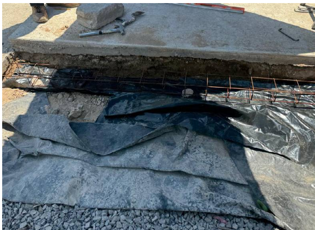
FIGURA 6. Colocación de plástico y acero horizontal Armex 10-14. Fuente: elaboración propia (2024).
