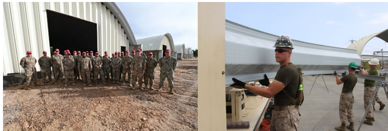
Figura 2. Proceso constructivo de sistema arcotecho. Fuente: Google (2025)
