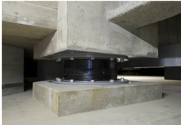
Figura 4. Aislador de Elastómero. Extraído de Tchamo & Zhou, (2018)
