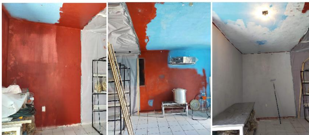
Figura 16. Impermeabilizado y pintura de la cámara de crecimiento.
