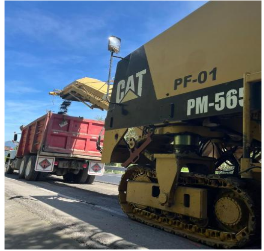
Figura 6-10 Equipo utilizado para proceso de fresado y barrido.
