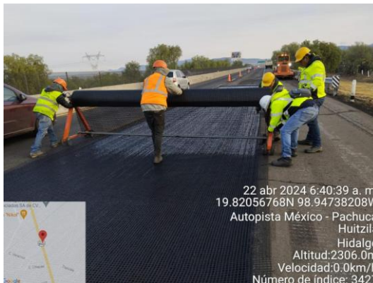
Figura 6-25 Colocación de geomalla de fibra de vidrio.
