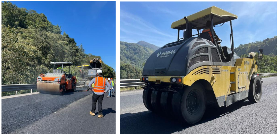
Figura 6-12 Equipo utilizado en la etapa de compactación.
