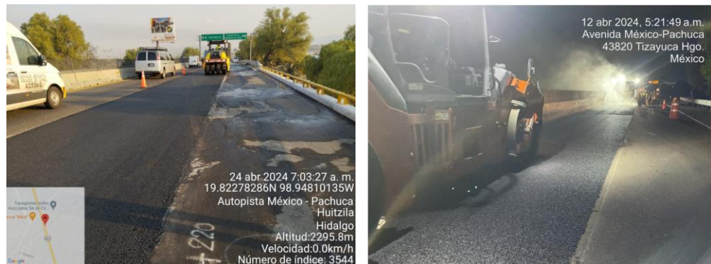
Figura 6-26 Etapa de compactación en caso estudio 2.
