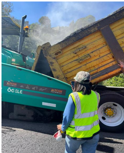
Figura 6-11 Equipo utilizado en la etapa de colocación.
