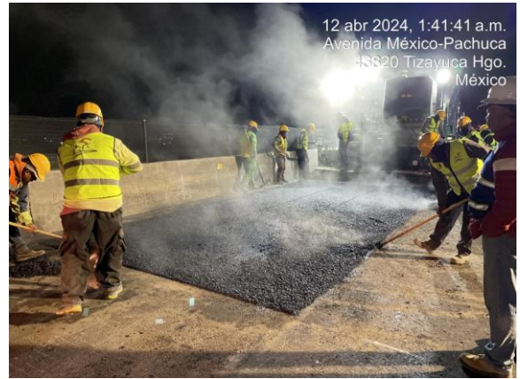
Figura 6-24 Colocación de la mezcla en caso estudio 2.
