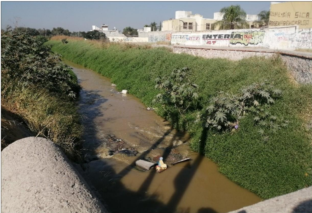
Figura 14. Dren El Arenal (antes arroyo jurica), al poniente de la ciudad de Querétaro. Fuente: Elaboración propia durante recorridos exploratorios, (2024).
