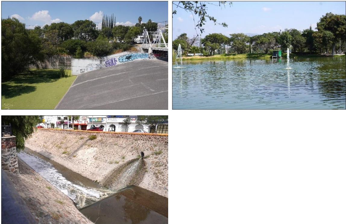
Figura 35. Salida del bordo de contención en el Parque 2000, estanque en el parque Alfalfares y salida de drenaje en el río Querétaro, en la zona media de la microcuenca Carrillo. Fuente: Elaboración propia durante recorridos exploratorios (2024)
