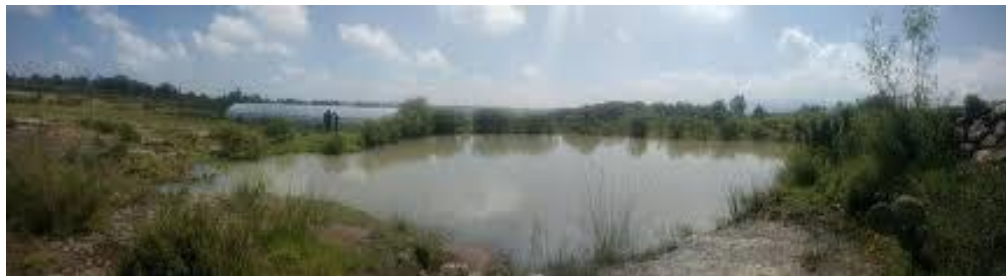
Figura 22 Sistema de captación y almacenamiento de agua pluvial llamado bordo con geomembrana para evitar la filtración (Aguilar Sánchez & Lara Aguazul, 2021)
