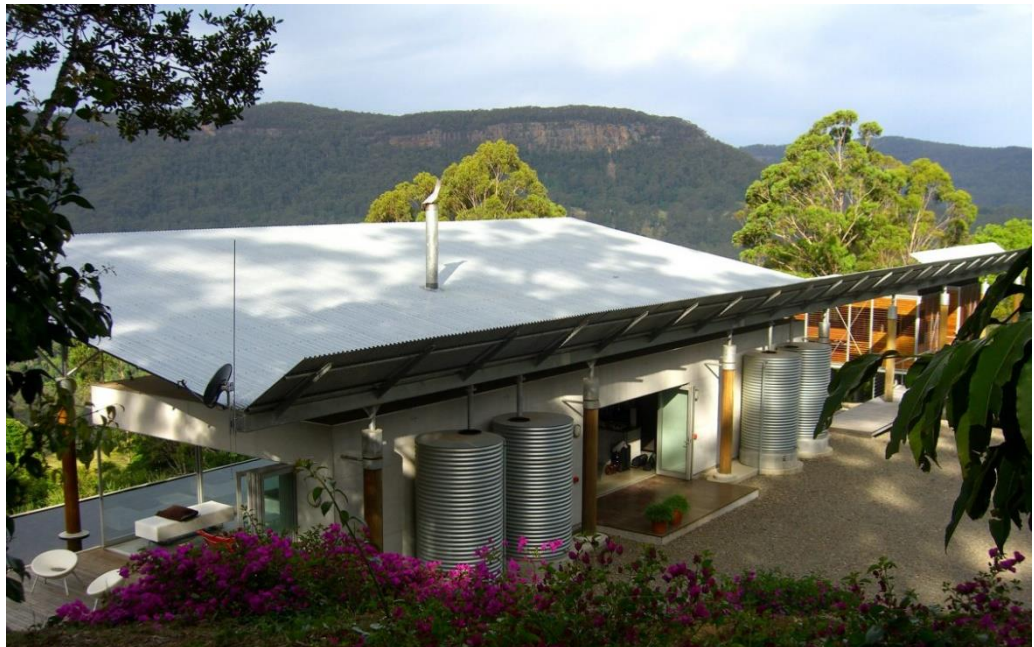
Figura 17 Sistema de captación de agua pluvial en Upper Kangaroo River, Kangaroo Valley, New South Wales, Australia (2030 Palette, 2025)
