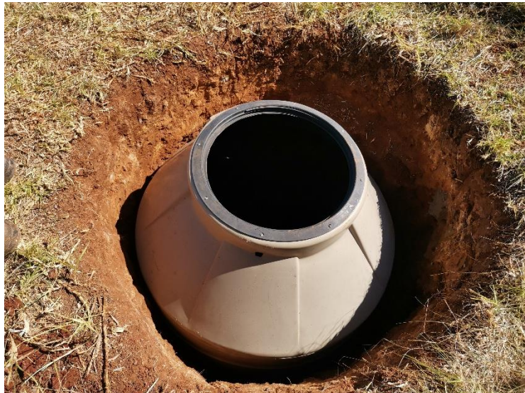
Figura 70 Excavación y colocación del sistema de almacenamiento (Elaboración propia)
