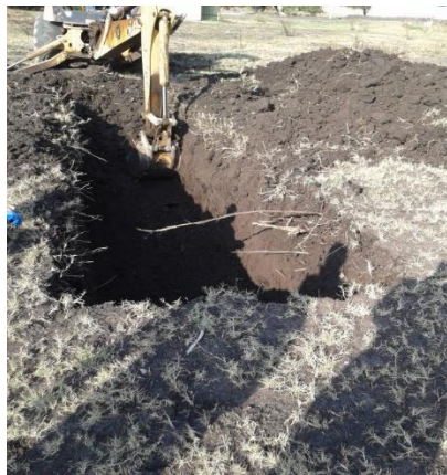
Figura 6-I. Extracción de muestras alteradas.
