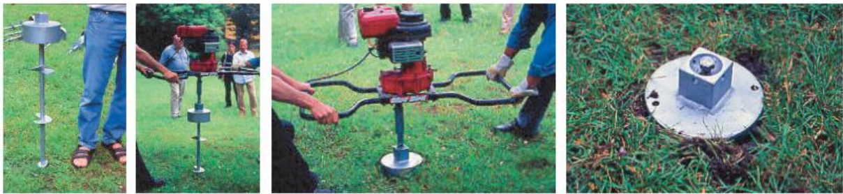
Figura 14. Instalación de anclajes de tornillo en el “TR 2003. Octavo Taller Internacional sobre Diseño y Realización Práctica de Estructuras Arquitectónicas de Membrana. Universidad Técnica de Berlín”. J. Llorens (2006)
