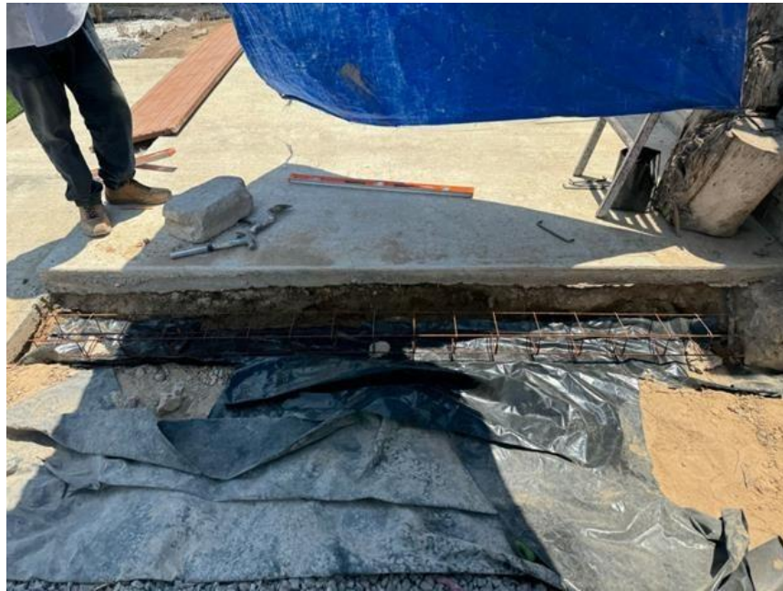
Figura 18. Colocación de plástico negro, y colocación de aceros horizontales para cimentación (Elaboración propia, 2024).
