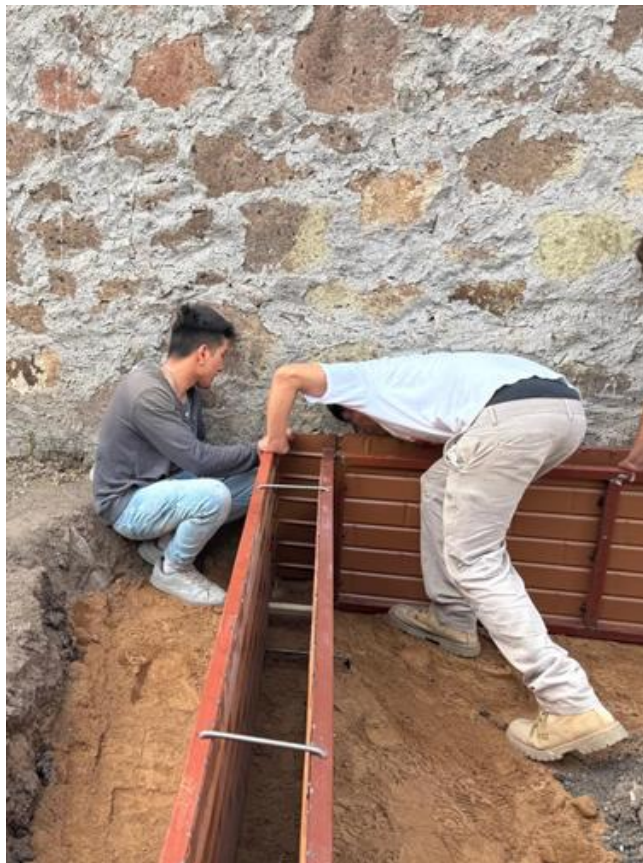
Figura 27. Armado del sistema constructivo PMS en la cepa previamente nivelada y compactada (Elaboración propia, 2025).
