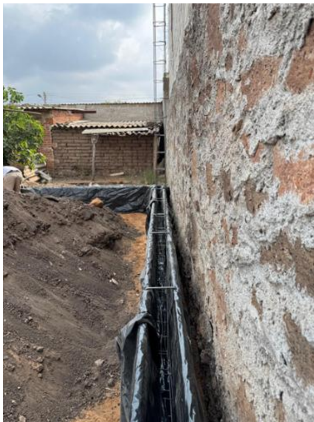
Figura 28. Colocación de plástico negro de construcción en forma de cuneta dentro del PMS (Elaboración propia, 2025).
