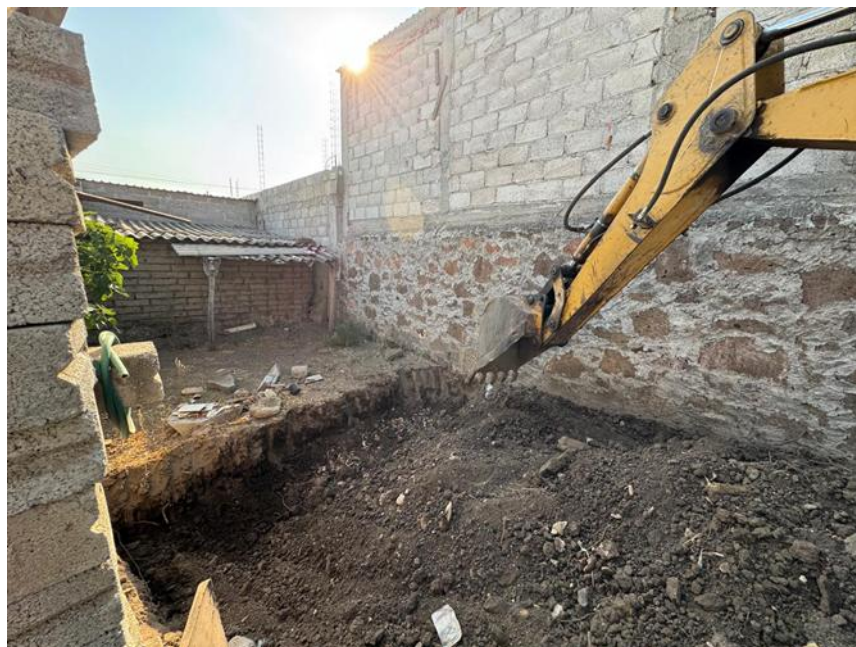
Figura 25. Retroexcavadora operando en la etapa de excavación (Elaboración propia, 2025).
