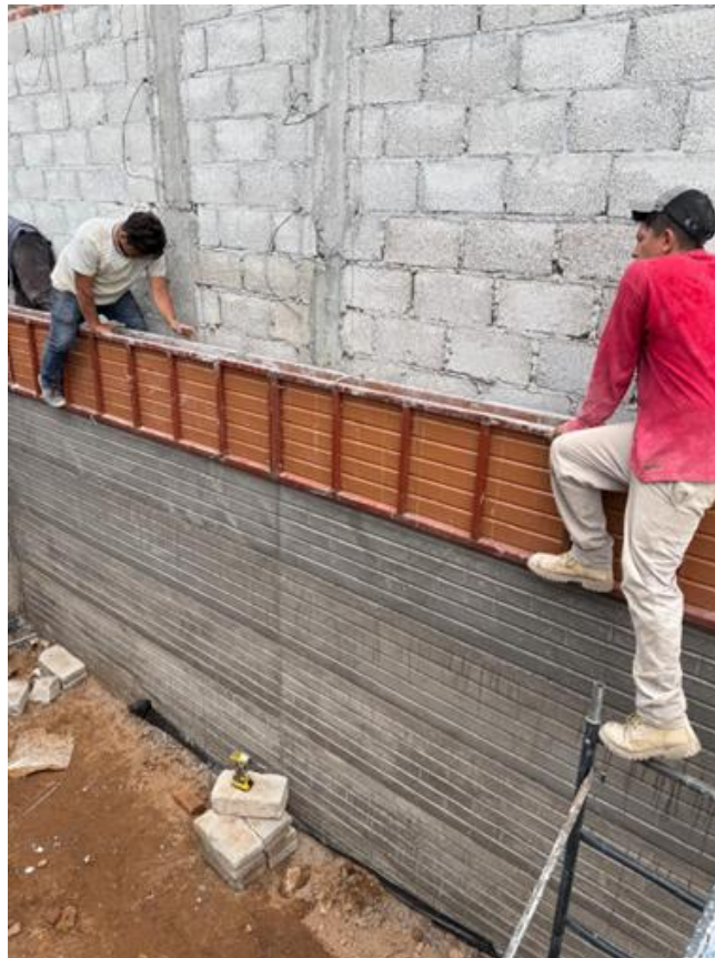
Figura 33. Preparación de la última línea para recibir el colado (sexto día de colado, quinta línea de albañilería) (Elaboración propia, 2025).
