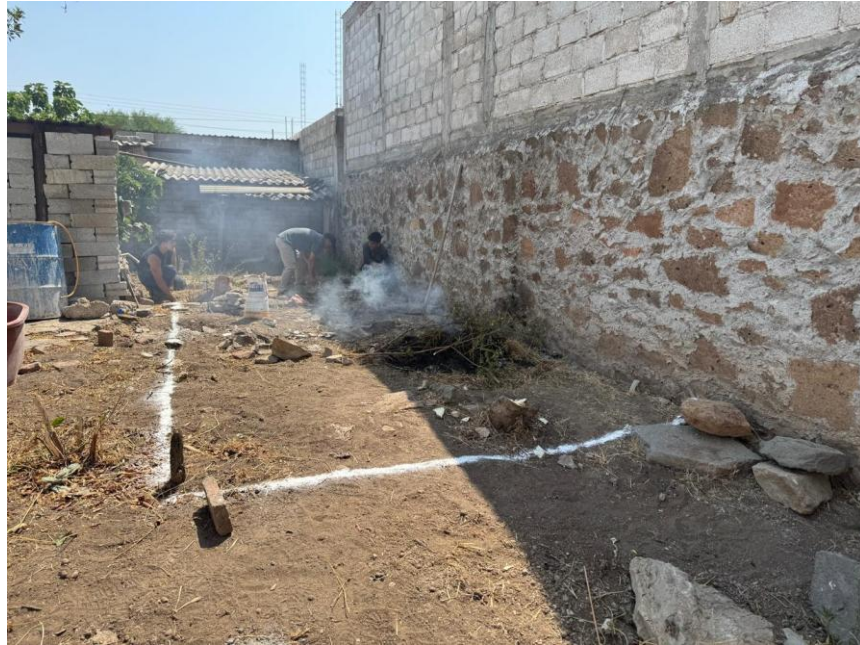
Figura 24. Trazo y nivelación en el sitio (Elaboración propia, 2025).
