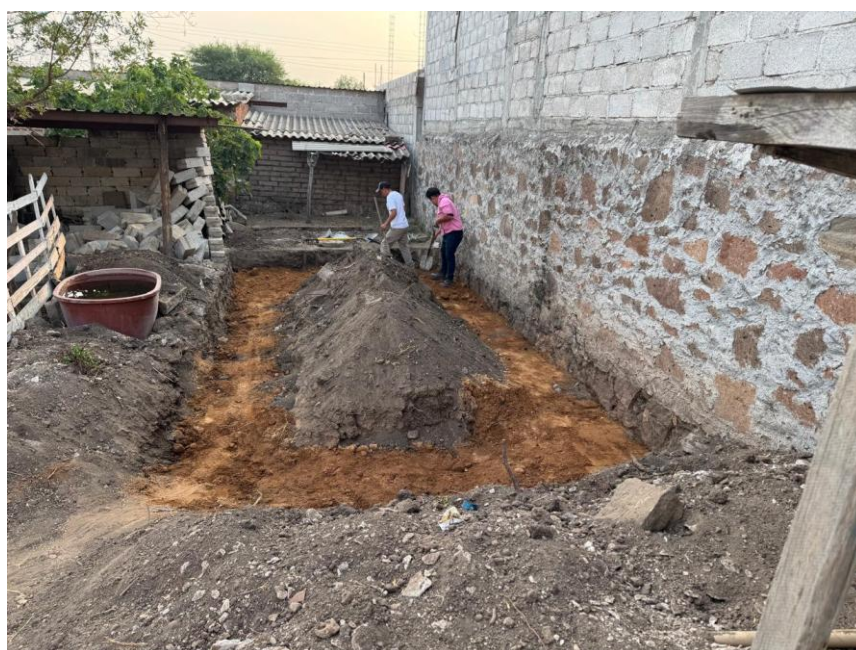
Figura 26. Relleno y compactación con tepetate de la cepa resultante de la excavación (Elaboración propia, 2025).
