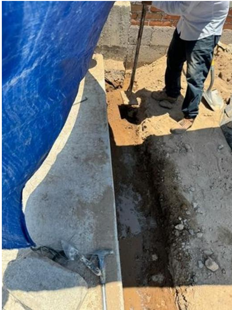
Figura 17. Ceba de 0.40 metros de profundidad y 0.30 metros de ancho (Elaboración propia, 2024).
