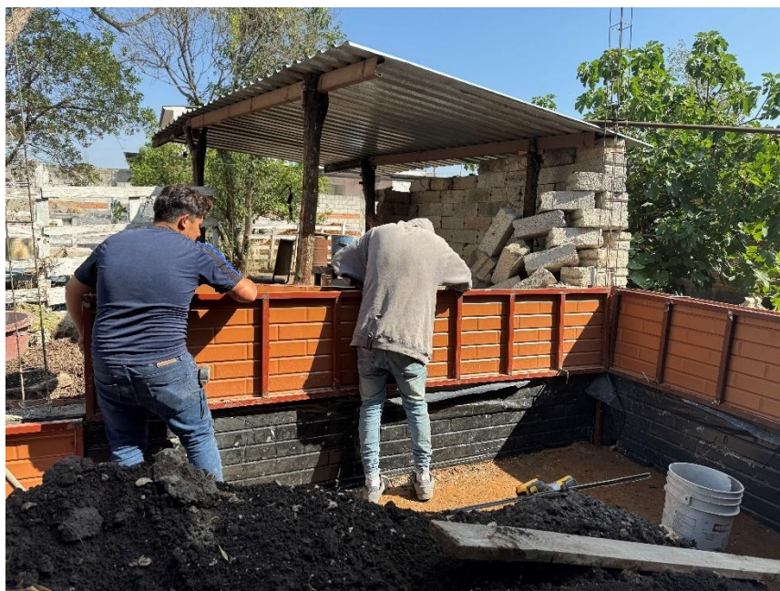
Figura 32. Montaje del PMS correspondiente a la etapa de estructura y albañilería (segundo día de colado, primera línea de albañilería) (Elaboración propia, 2025).
