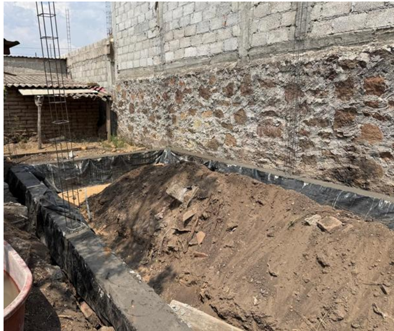
Figura 30. Colado concluido del primer día de utilización del PMS correspondiente a la etapa de cimentación. (Elaboración propia, 2025).
