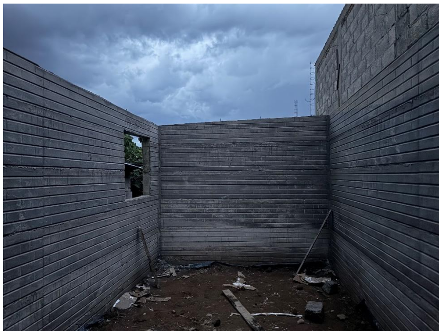
Figura 36. Tercera fotografía del producto final (aperturas- vanos en sistema constructivo PMS) (Elaboración propia, 2025).
