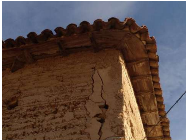
Figura 38. Agrietamiento de tapial por falla de conexión con alero en Belmonte de Gracián, España (2021).
