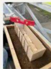
ENCOFRADO Y NIVELADO
