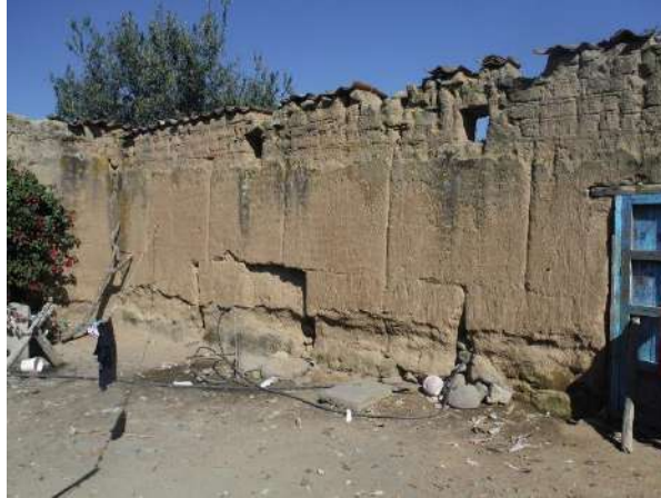
Figura 37. Barda de tapial hundida en vivienda de San Andrés Calpan, Puebla (2022).
