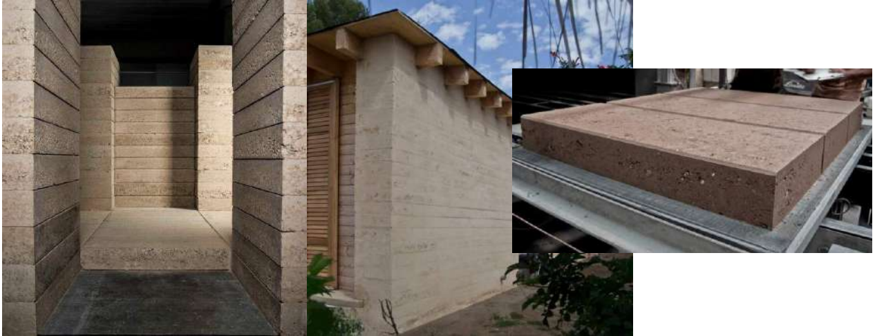
Figura 18. Bloque prefabricado de tierra natural compactada de la empresa Tectónica (2020).
