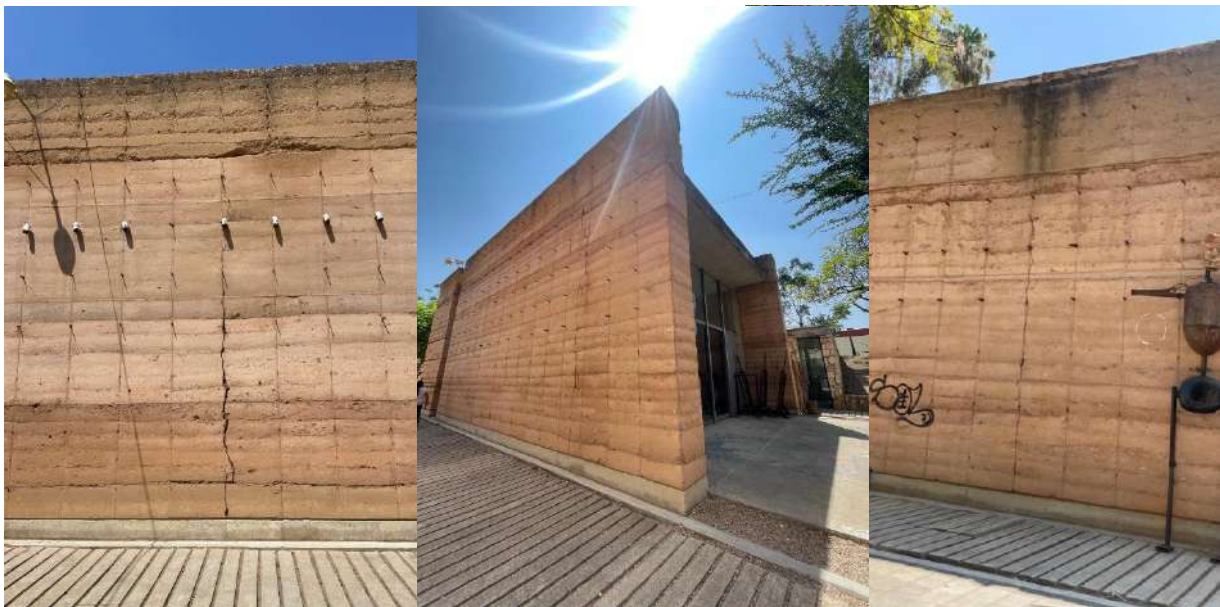
Figura 36. Escuela de Artes de Oaxaca, grietas en los muros de tapial (2024).
