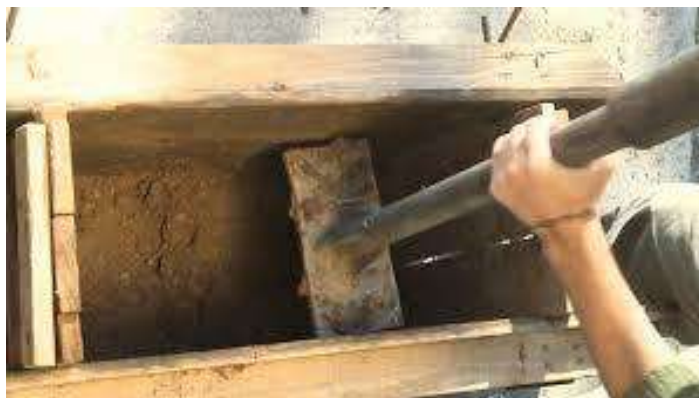
Figura 17. Apisonado por medios manuales (2016).
