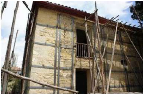
Figura 25. Edificación de tapial reforzado con placas de acero (2022).
