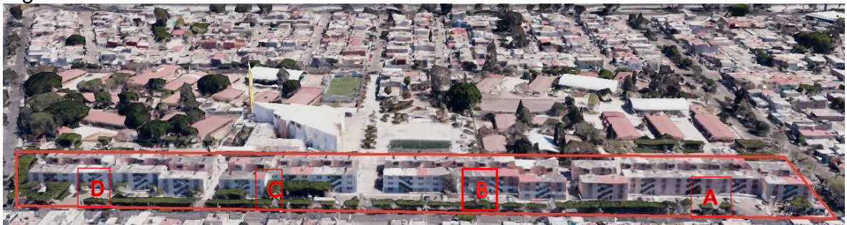
Fig.8: Los edificios condominales de “Los Sauces” 2024.
