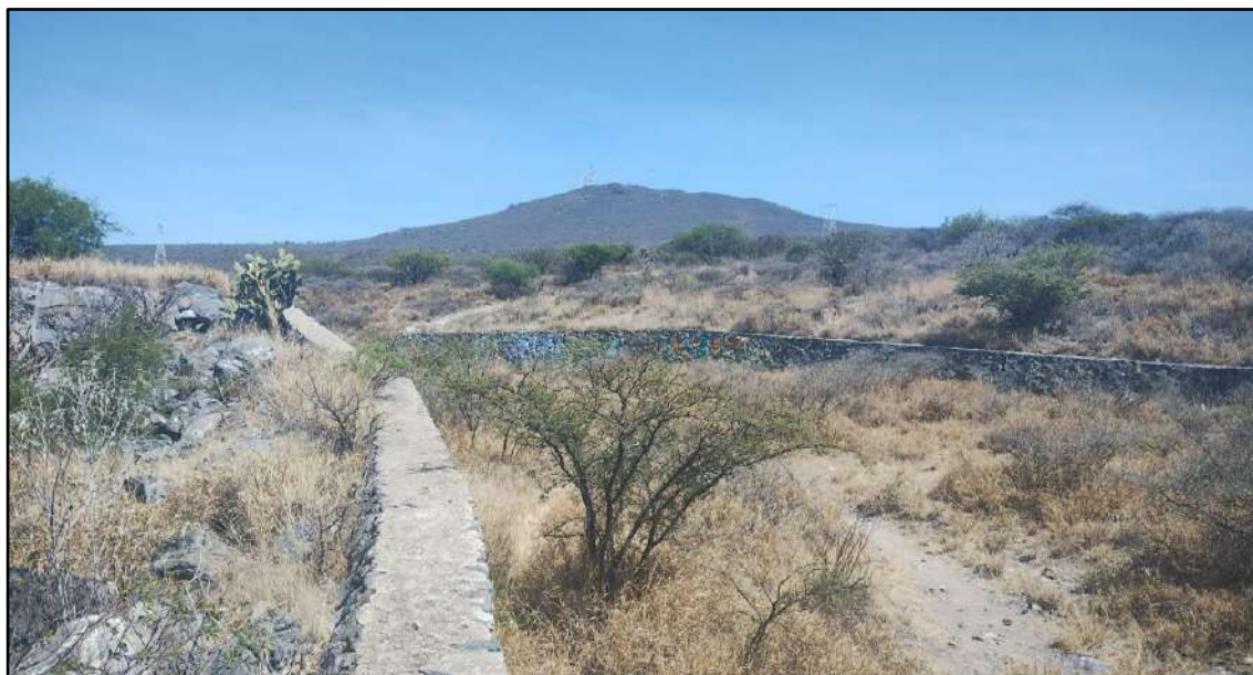
Figura 7. Vista de inicio del vertedor, a un costado de la cortina.
