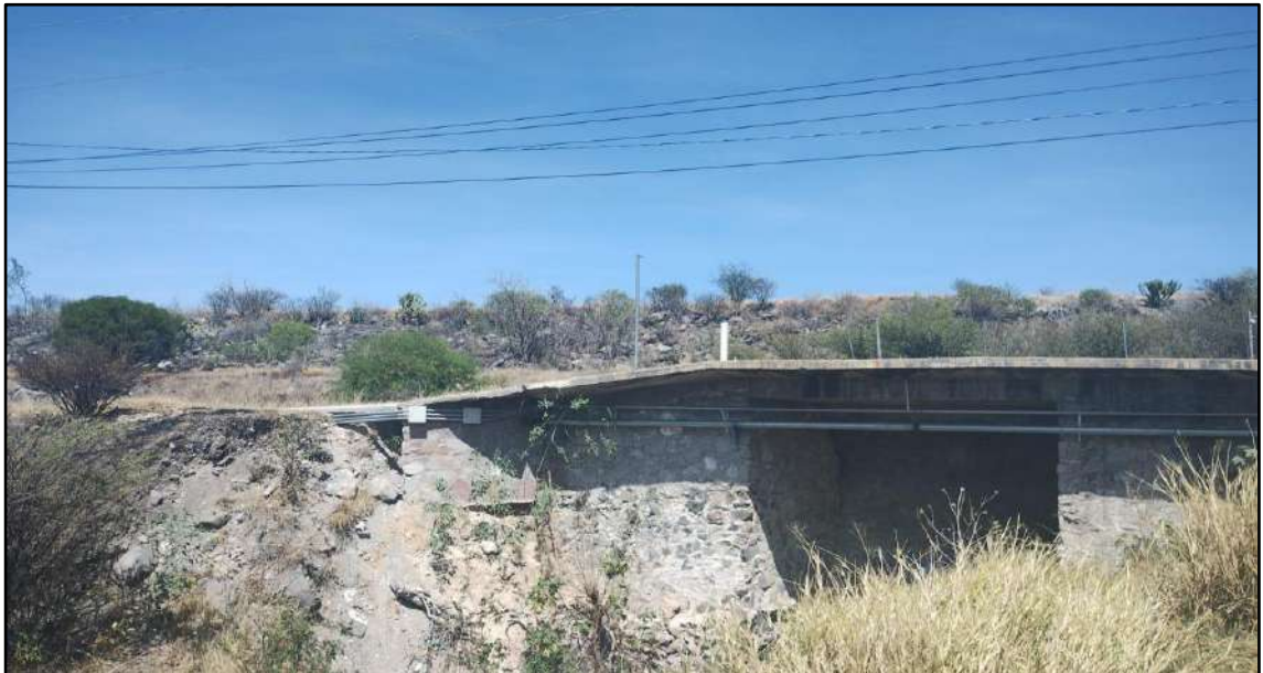
Figura 9. Puente de vialidad por donde sigue el flujo del agua.
