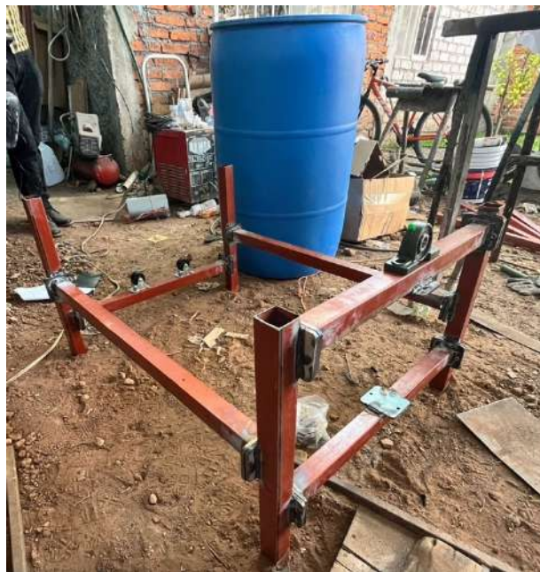
Figura 22. Montaje de biodigestor (Fuente propia)
