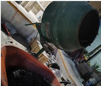
Figura 41: Revolvedora ocupada en la elaboración de todas las mezclas
