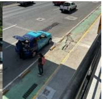
Figura 261. Pérez, P. I., (2024) Hueco nuevo, asfalto nuevo [jpg], Querétaro.
