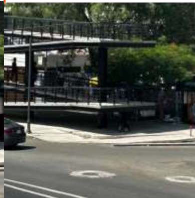
Figura 260. Pérez, P. I., (2024) Techo de concreto [jpg], Querétaro.
