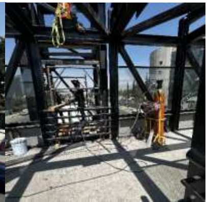
Figura 215. Pérez, P. I., (2024) Tanque [jpg], Querétaro.
