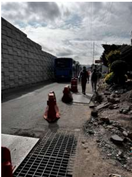
Figura 16. Pérez, P. I., (2023) Zona de riesgo [jpg], Querétaro.
