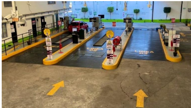
Figura 2.2 Centro de verificación vehicular de la ciudad de México (Córdova, 2020).
