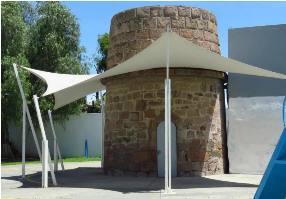
Ilustración 9. Antigua base para tanque de agua del Ferrocarril de Querétaro a Acámbaro. Fuente: Alejandro Núñez Lara
