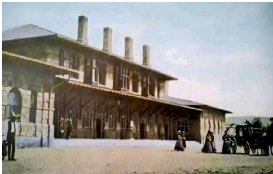
Ilustración 5. Vista a la Estación del Ferrocarril 1905. Fuente: Fotos del Querétaro actual y antiguo https://www.facebook.com/groups/131007370793142
