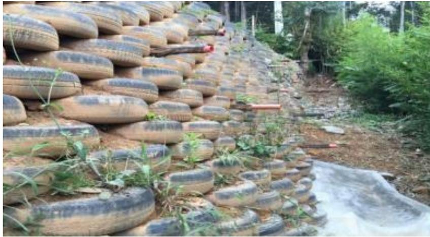
*Ilustración 13. Muro de tierra reforzado con neumáticos de desecho construido en Musicreando, sector las palmas del municipio de Medellín. [26]*
