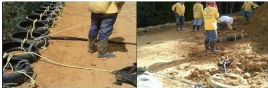
*Ilustración 17. Amarre entre neumáticos y tensores.*
