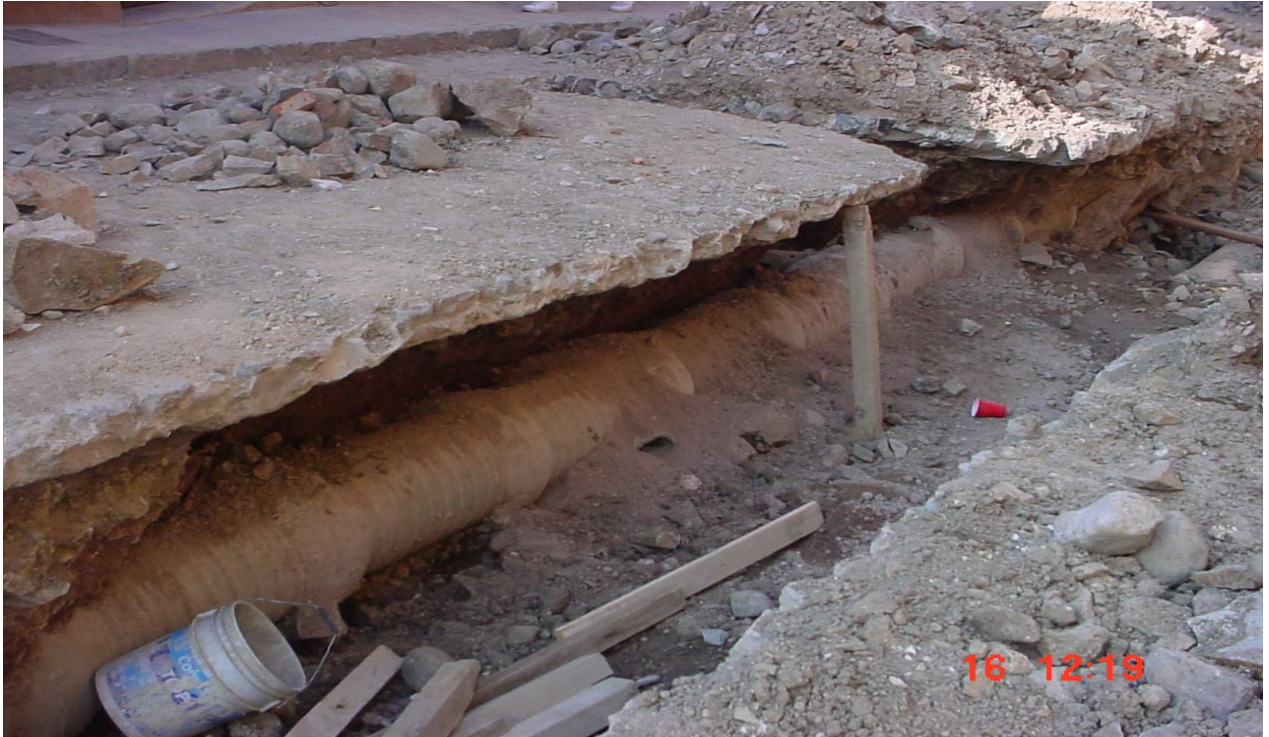
Vista del colector antiguo de concreto simple.
