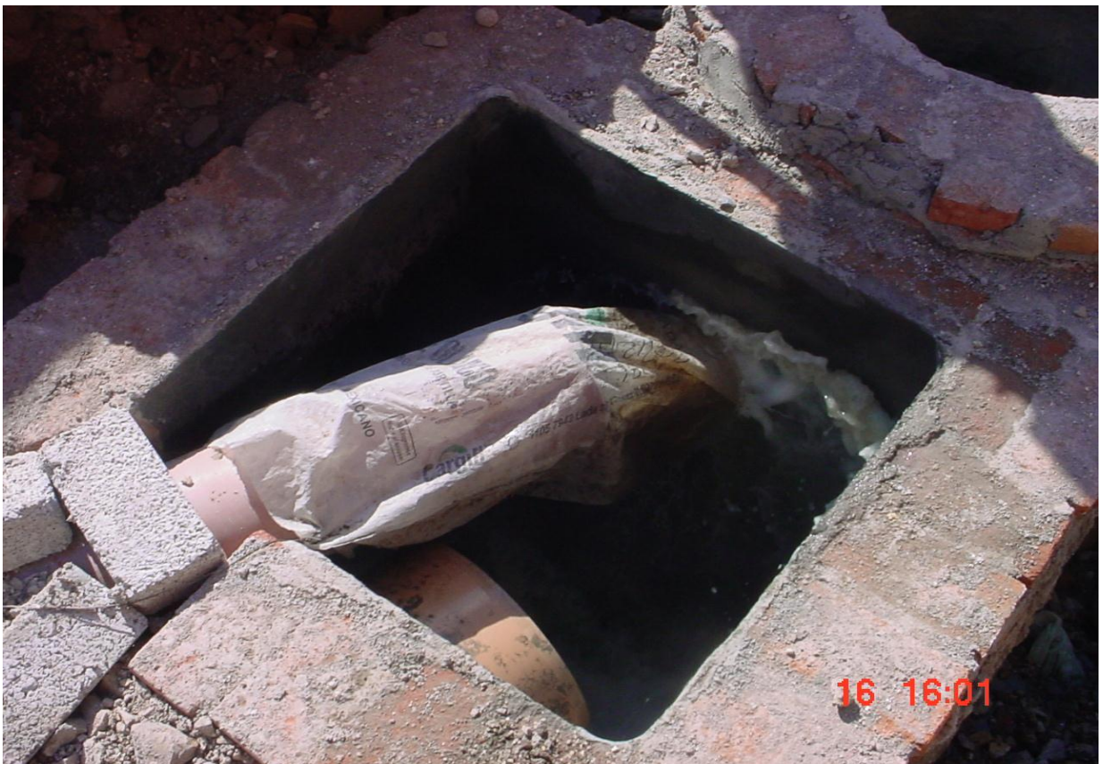
Desviación provisional de aguas negras del colector antiguo de concreto a la línea nueva de 25 cm que descarga provisionalmente después del pozo de visita en el colector de 45 cm, esto con el fin de poder seguir instalando tramos de tubería del colector de 25 cm.
