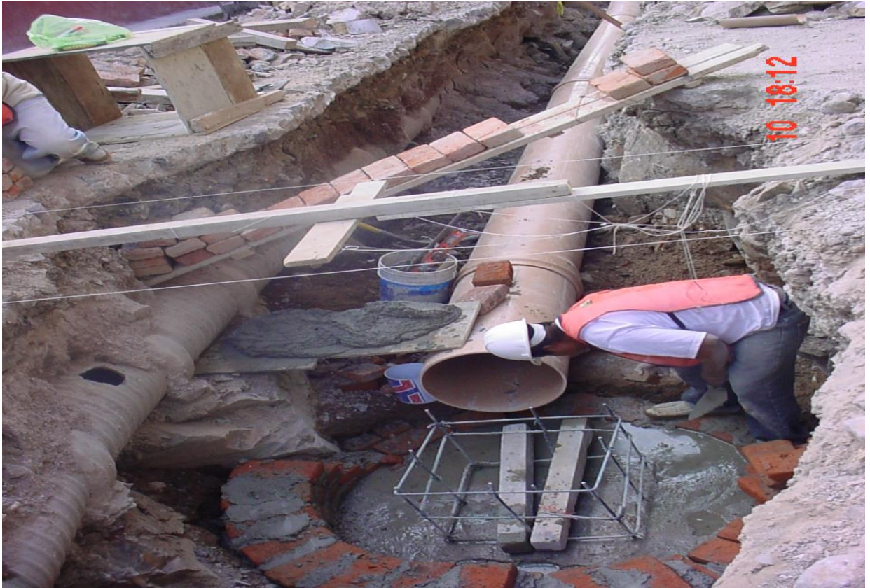
Construcción de pozo de visita con lavadero de concreto, que evita la erosión de la base del pozo, este tipo de pozos son construidos para caídas menores a 50 cm.
