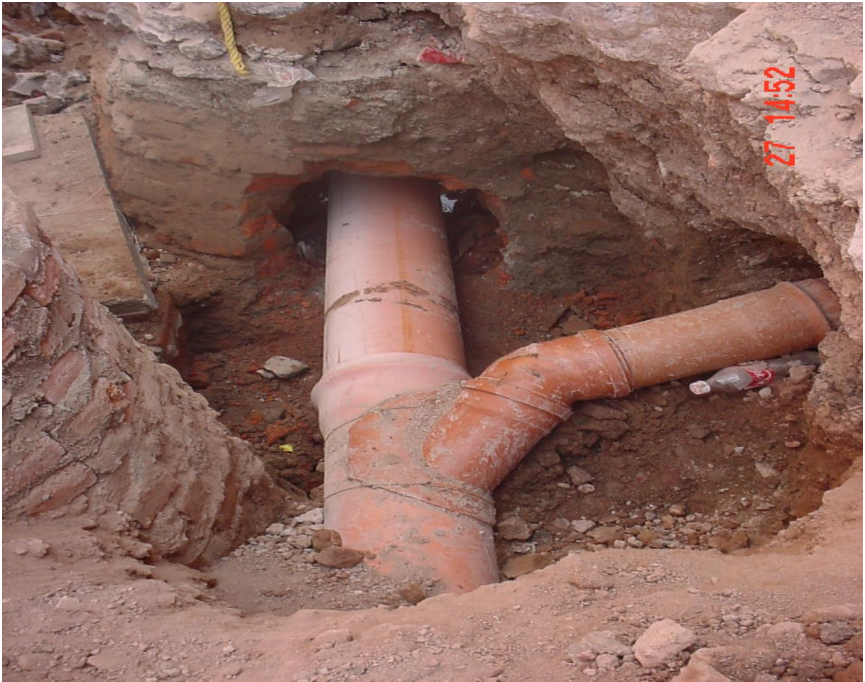
Rehabilitación de una descarga sanitaria al colector de aguas negras de 25 cm. Instalado en forma paralela al colector principal de 45 cm. Se puede apreciar la silleta, el codo y la tubería de descarga.
