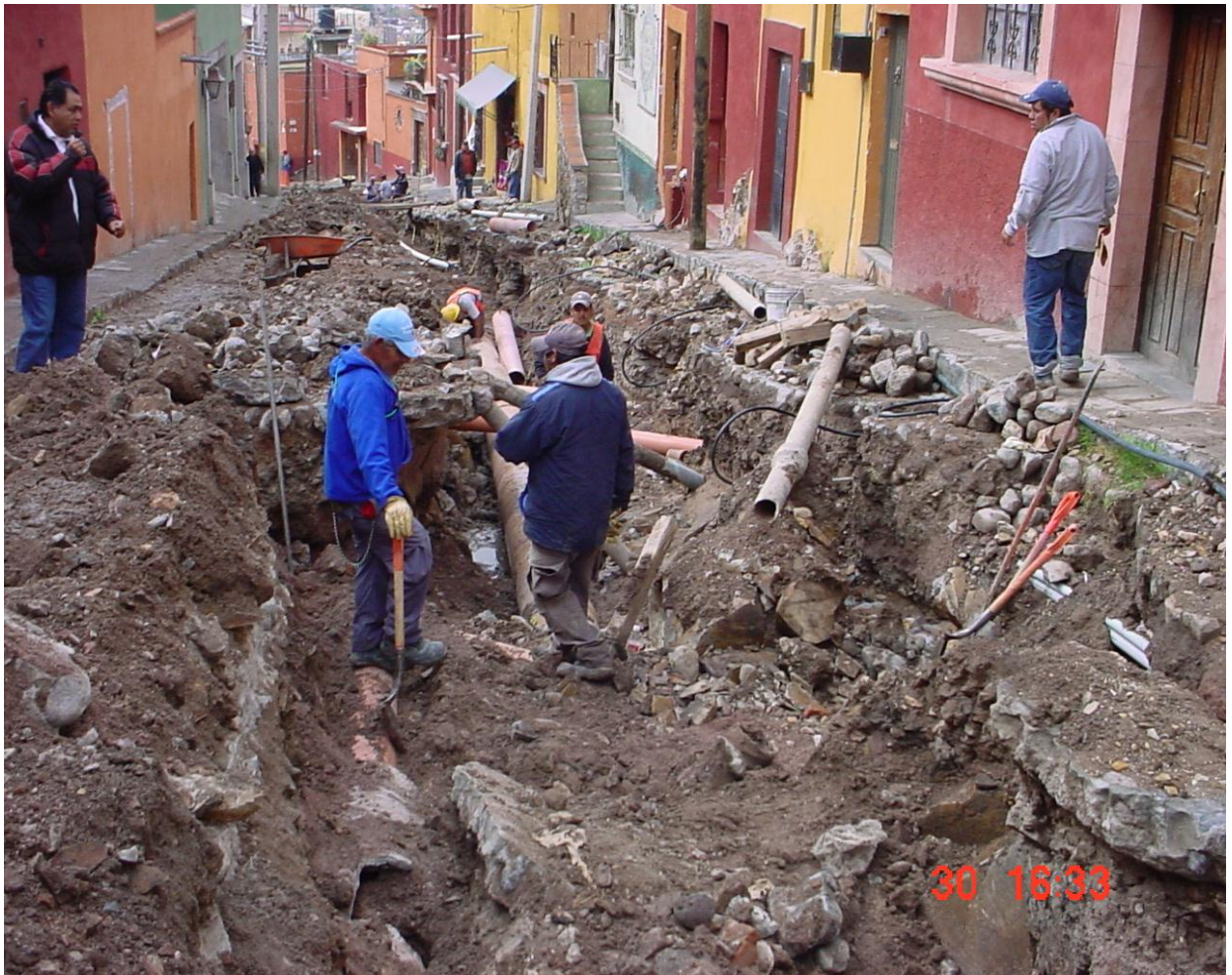
Derrumbe de taludes y levantamiento de plantilla provocados por las lluvias, además las líneas ya instaladas de drenaje fueron removidas por el agua de lluvia.
