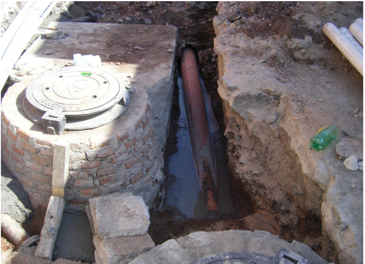
Suministro e instalación de tapas y brocales.
