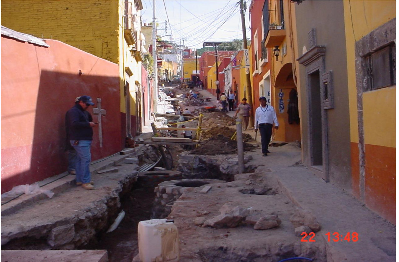
Vista de la primera etapa de trabajo en la calle de Homobono.
