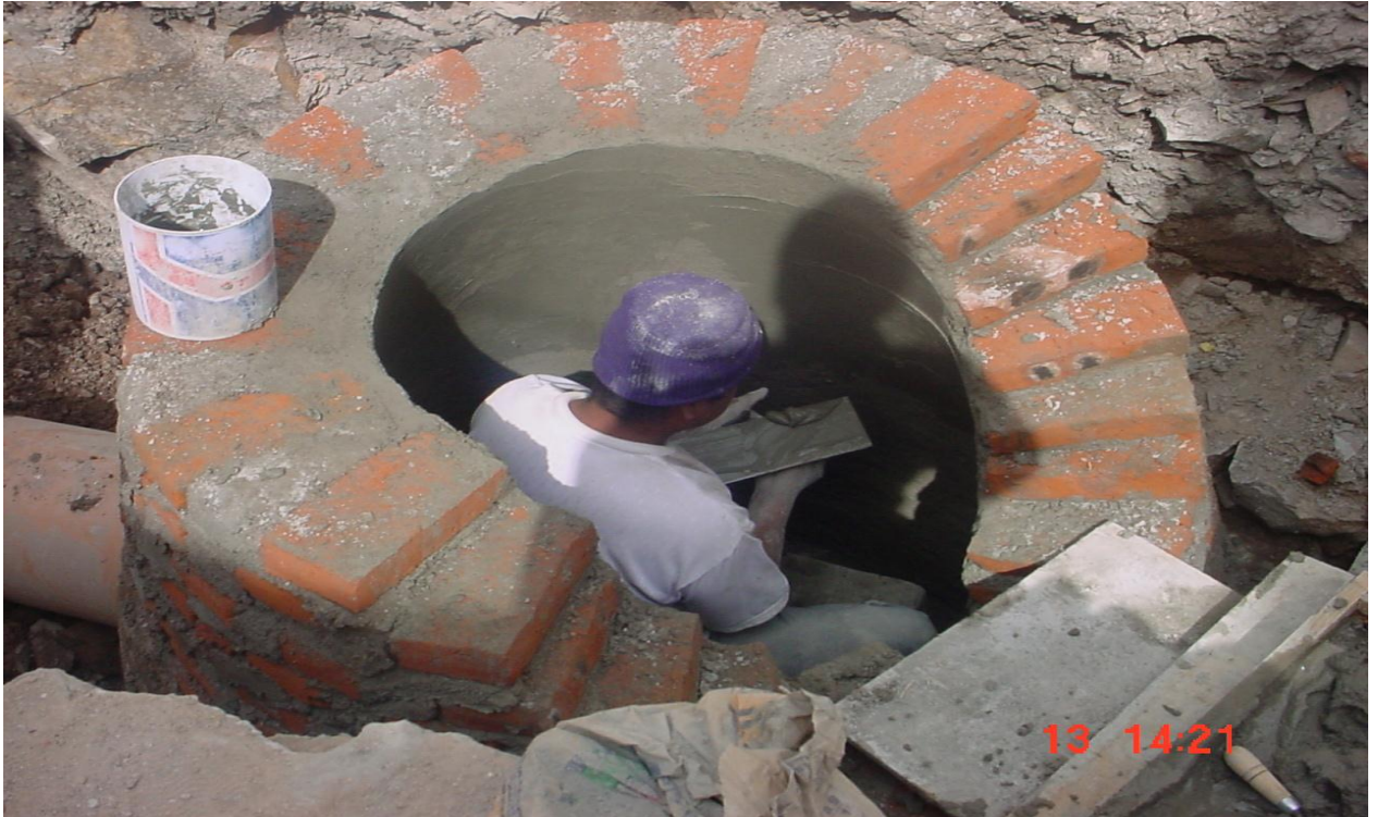
Aplanado y pulido de cemento al interior del pozo de visita.
