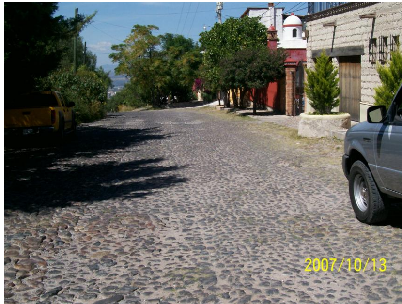
Inicio de colector (vista aguas arriba)
