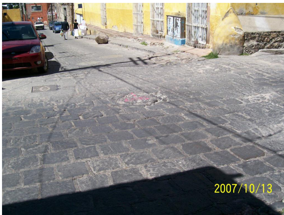
Punto donde termina la rehabilitación
