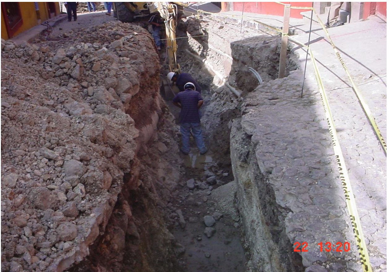
Excavación de zanja en material tipo c por medios mecánicos para instalación de la línea.
