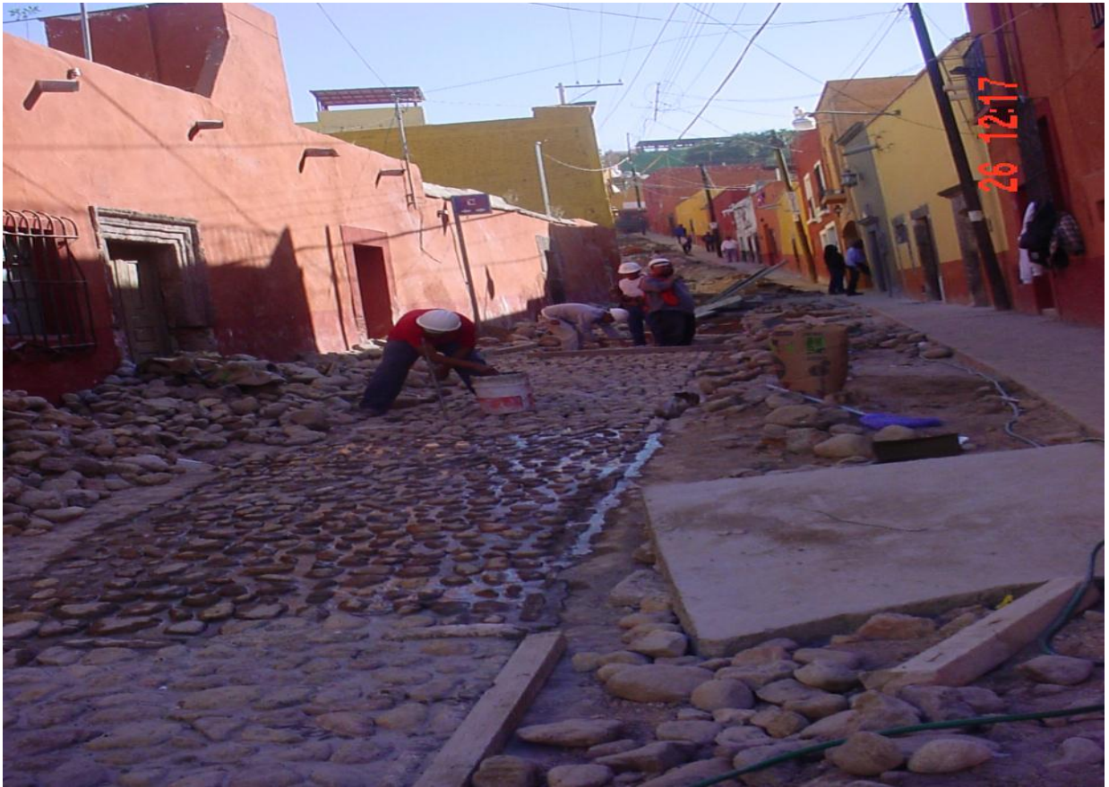
Reposición de pavimento de piedra bola asentado con mortero cemento arena.
