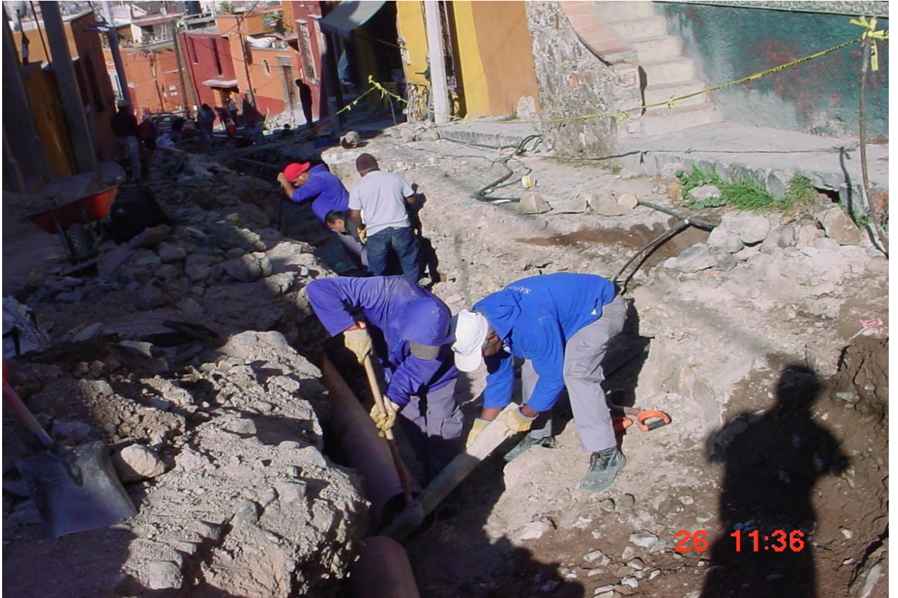
Instalación de tubería de PVC de 25 cm.
