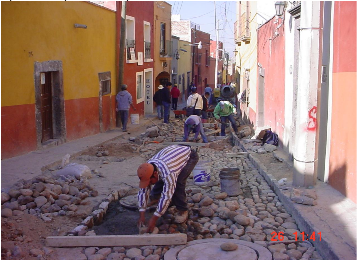
Reposición de pavimento de piedra bola asentado con mortero cemento arena.
