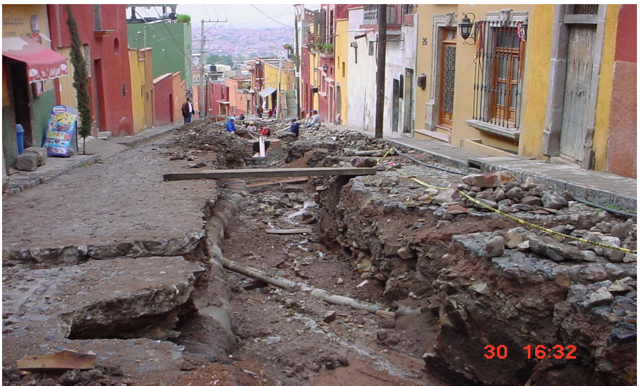
Derrumbe de taludes y levantamiento de plantilla provocados por las lluvias, además las líneas ya instaladas de drenaje fueron removidas por el agua de lluvia.
