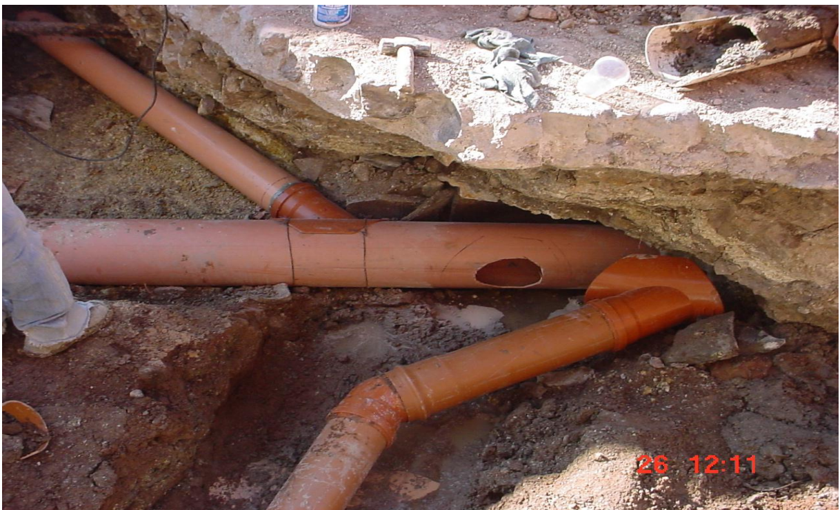
Rehabilitación de una descarga sanitaria al colector de aguas negras de 25 cm. Instalado en forma paralela al colector principal de 45 cm. Se puede apreciar la silleta, el codo y la tubería de descarga.
