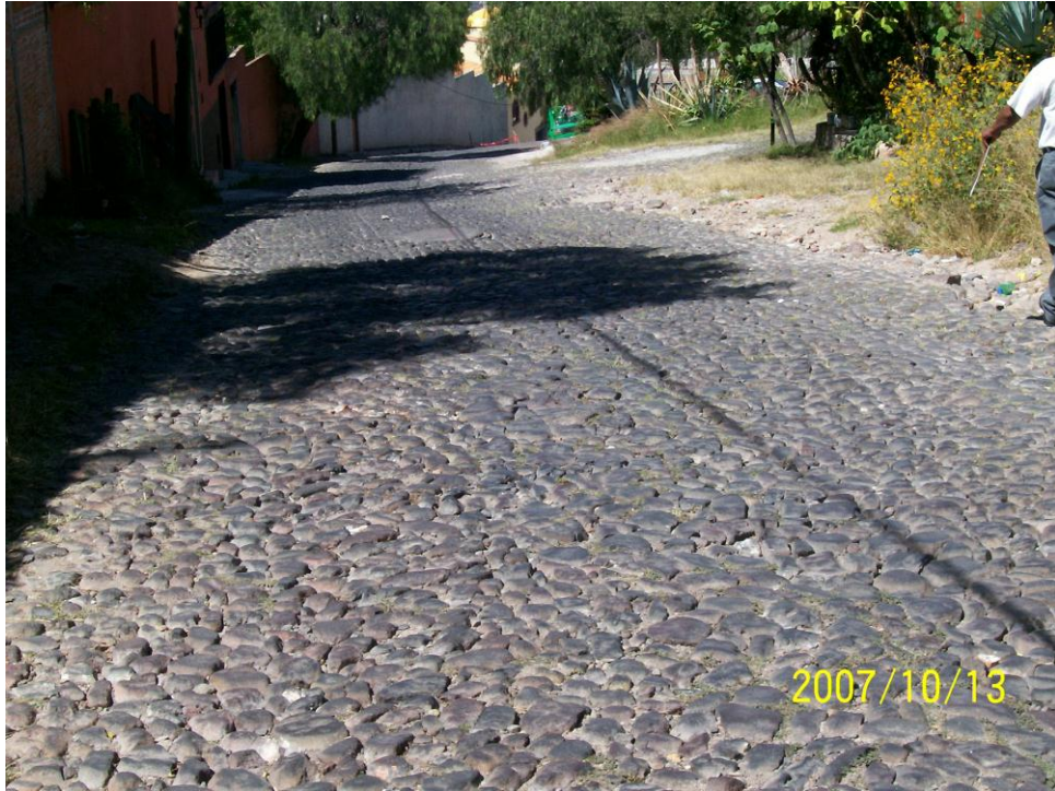
Vista donde se aprecia la gran pendiente existente
