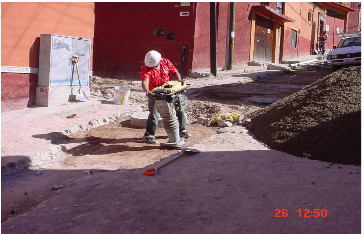
Relleno y compactado de zanja con tepetate de banco.
