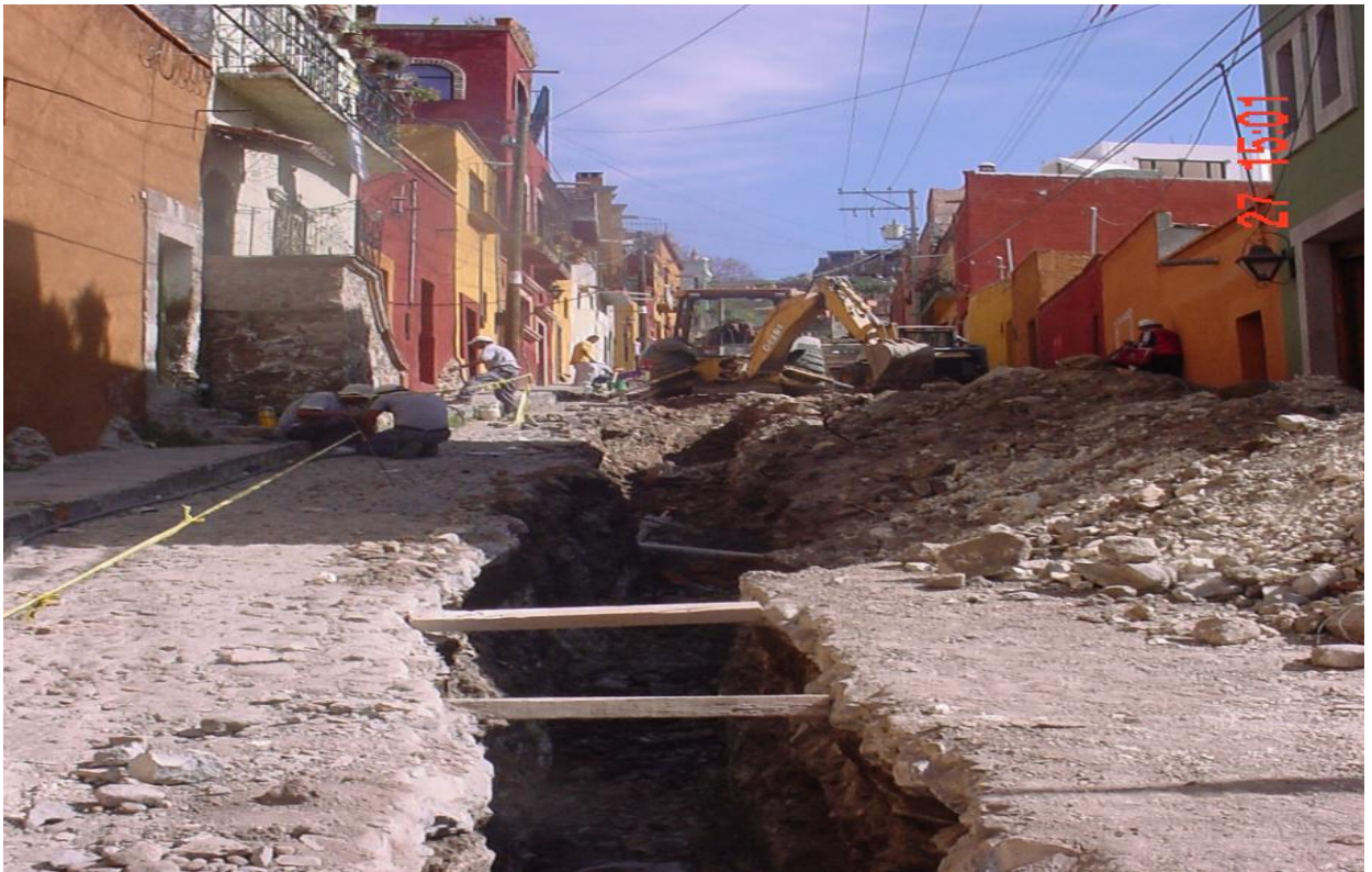
Ruptura de pavimento y excavación de zanja para instalación de la tubería.
