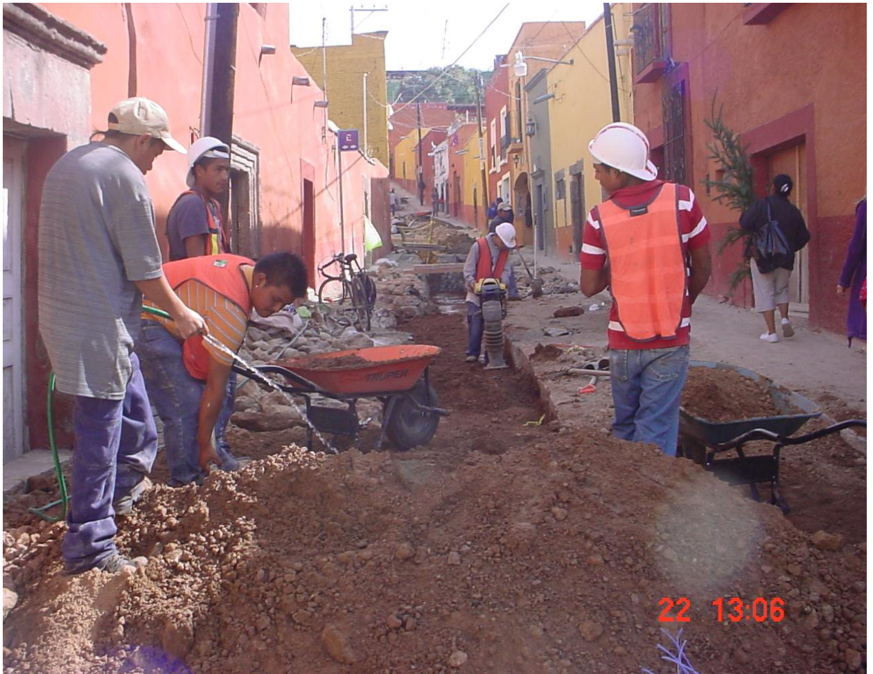
Relleno y compactado de zanja con tepetate de banco.
