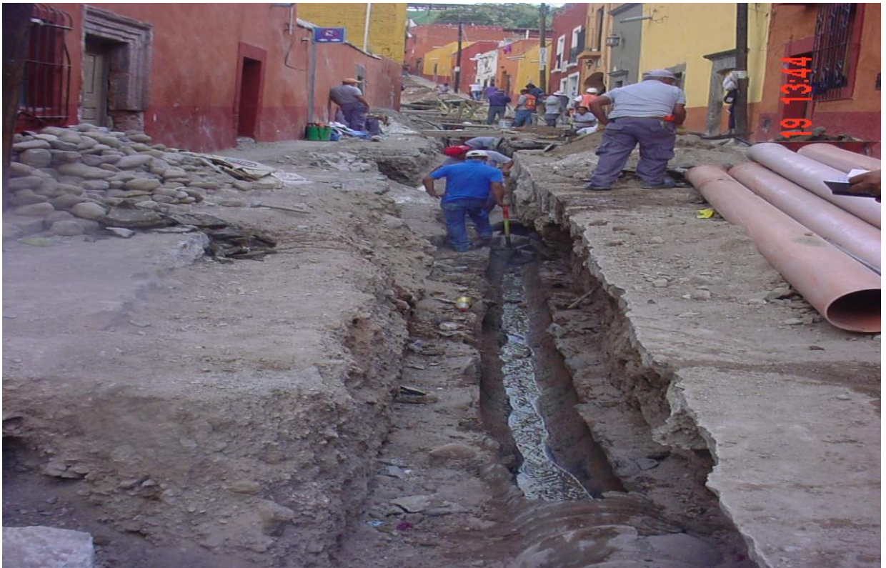
Sustitución de la tubería de concreto simple del colector antiguo con un diámetro de 30 cm a un diámetro de 25cm para descargas de aguas negras exclusivas de la calles de Cuesta de San José y Homobono.
