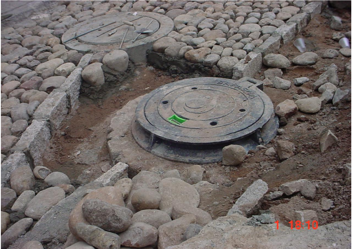
Suministro e instalación de tapas y brocales.
