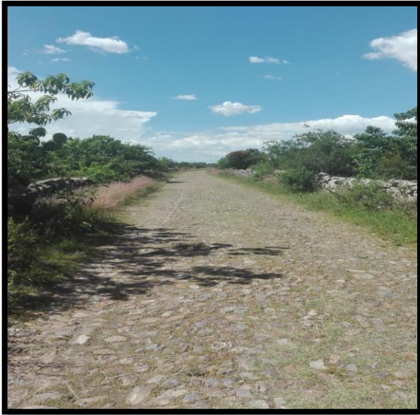
Imagen 1. Falta de iluminación
