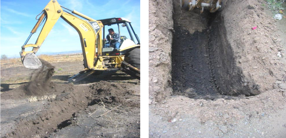
Figura 4.16 Realización de pozo a cielo abierto (PCA)
