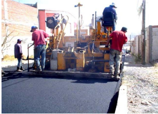
Figura 4.32 Construcción de carpeta asfáltica.
