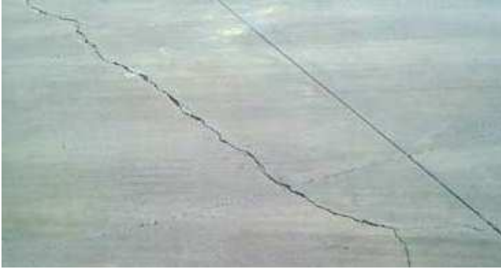
Figura. 6.3 Agrietamiento longitudinal.
