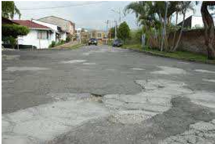
Figura 4.8. Mala construcción de parches.
