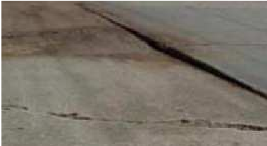
Figura 6.6 Hundimiento
