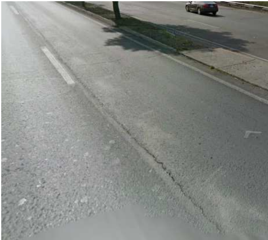
Figura 5.8 Agrietamiento transversal.
