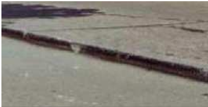
Figura 6.5 Levantamiento de losa.
