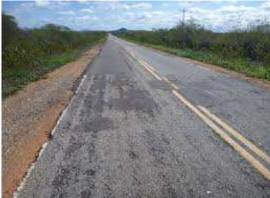
Figura 4.14 desgaste de un camino de dos carriles.
