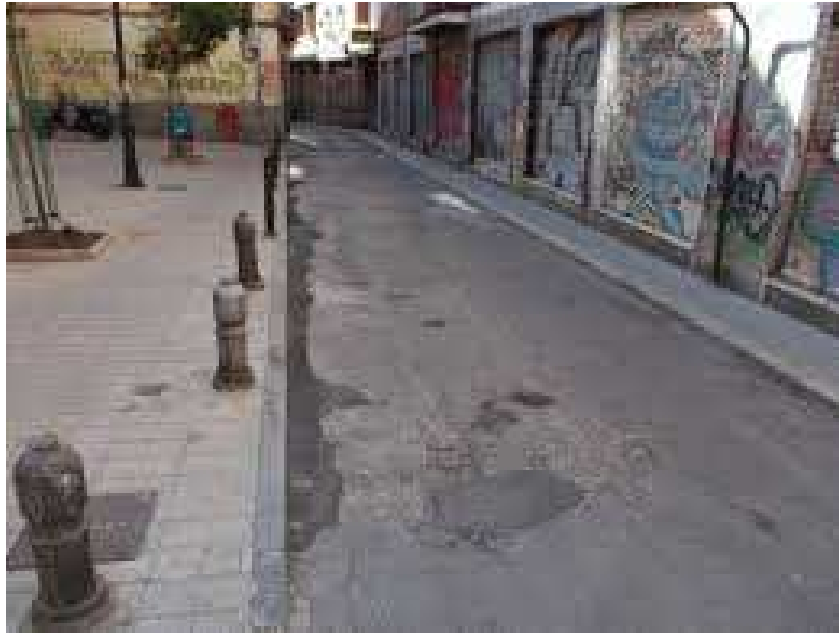
Figura 4.7. Parche deteriorado.
