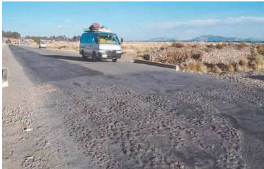
Figura 4.13. Desgaste de una avenida hasta llegar a capas inferiores.
