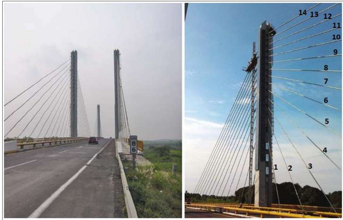
Figura 1. 2 Puente Rio Papaloapan y enumeración de tirantes.
