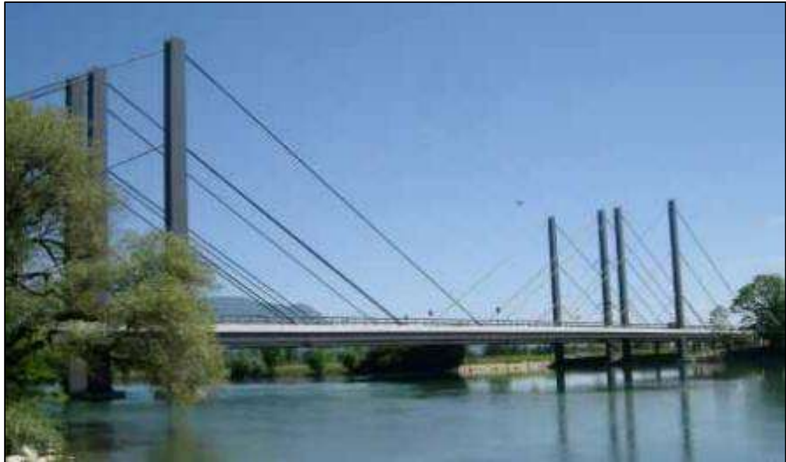
Figura 3 Puente Riddes en Suiza. Es una estructura atirantada con un sistema de suspensión en tres planos [14].
