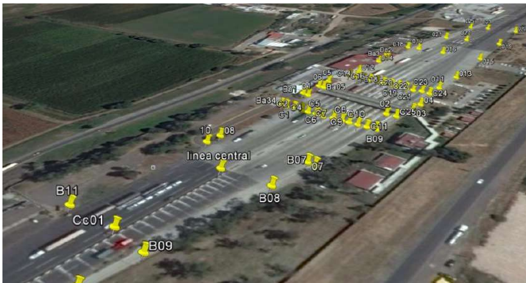
Figura 3: Puntos de referencia del levantamiento topográfico en la caseta de cobro Palmillas
