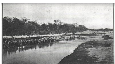
Canal de Vizam, retanada en la obra de Leochitago
