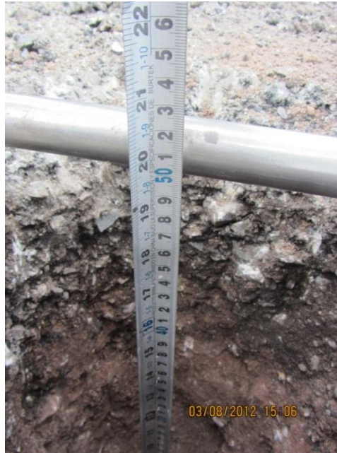
Figura III.8. Medición de espesor de la subbase
