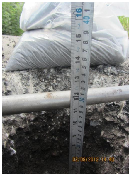
Figura III.7. Medición de espesor de la base
