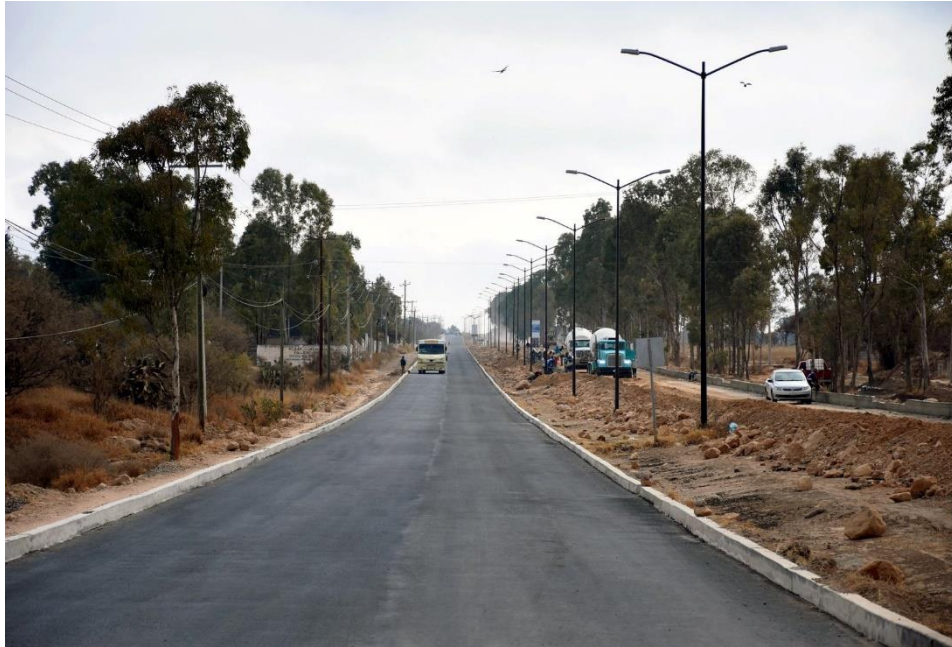
Imagen 1. Municipio Ezequiel Montes. (2018). Modernización de Carretera Estatal 131
