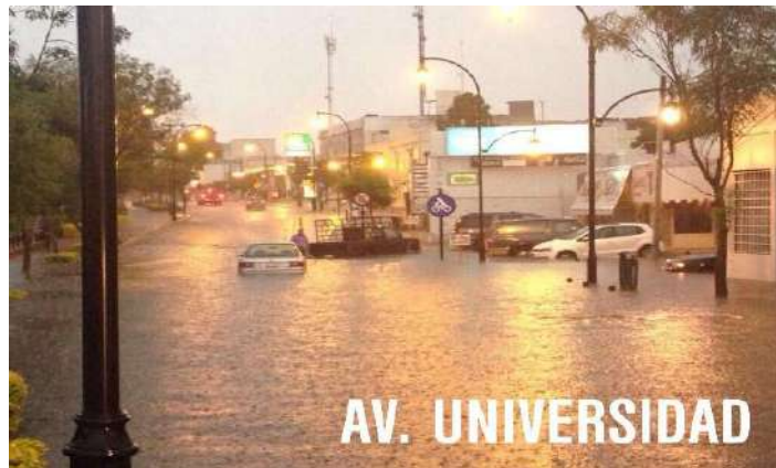
Figura 1.1 Falta de capacidad hidráulica del Río Querétaro. Fuente: Periódico Diario de Querétaro, 2017.
