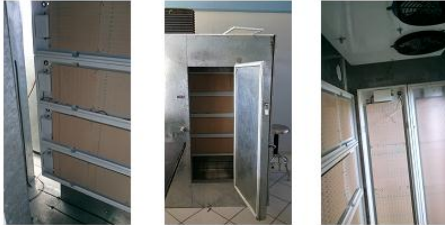
Figura 3.2.2.1 Instalación de lámparas LED en el interior del fitotrón.
