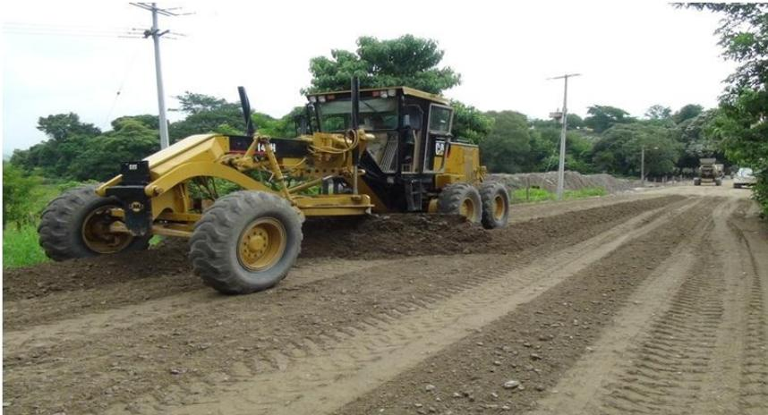
**Ilustración 15. Tendido de base hidráulica en camino, mediante moto conformadora.**
