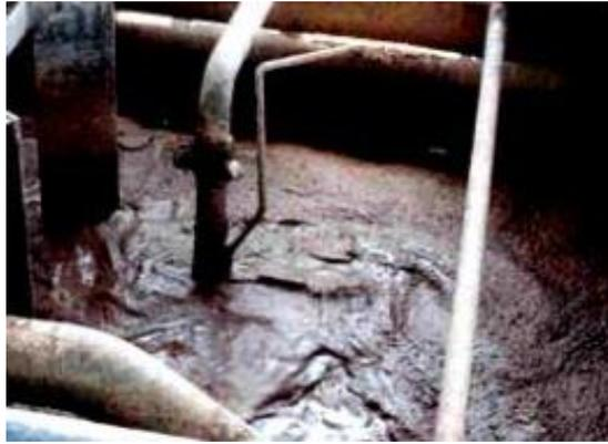
**Ilustración 6. Lodo de perforación base bentonita utilizado para revestir las paredes del pozo y evitar derrumbes.**
