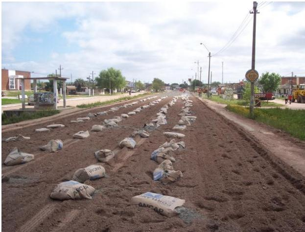
**Ilustración 16. Base hidráulica mejorada con cemento gris, con la finalidad de aumentar su capacidad de carga.**
