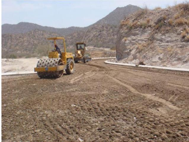
**Ilustración 13. Terracería conformada a base de tepetate, tendida con moto conformadora.**
