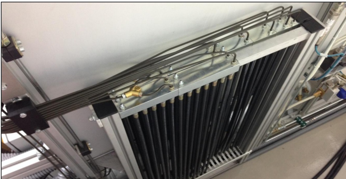
Figura 5-12 Conexión de conjuntos de mangueras.
