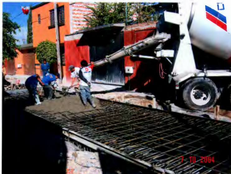
Figura 6.35 Vista de colado de losa superior.
