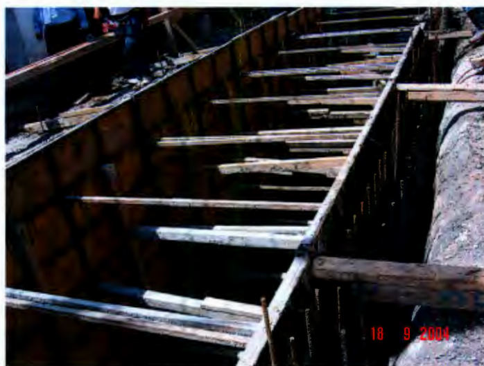
Figura 6.33 Cimbra interior en muros del dren, utilizando bastidores y separadores metálicos.
