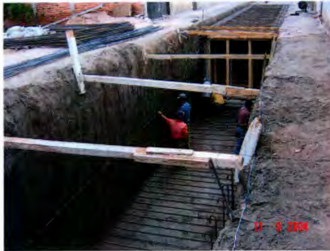
Figura 6.31 Proceso de armado de acero de refuerzo en losa inferior y muros laterales.
