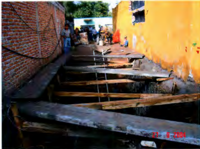
Figura 6.29 Proceso de construcción del dren en zonas de muy alto riesgo.
