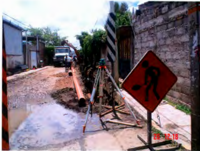
Figura 6.19 Trabajos de construcción de las nuevas instalaciones a los lados de Privada de la Flor.
