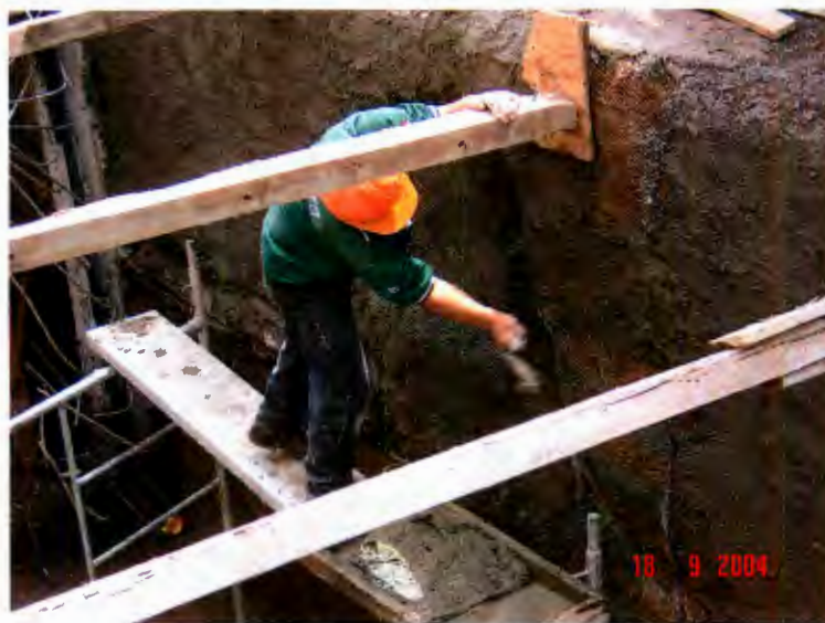
Figura 6.27 Proceso de aplanado con mortero cemento-cal-arena en talud, posterior a colocación de metal desplegado.
