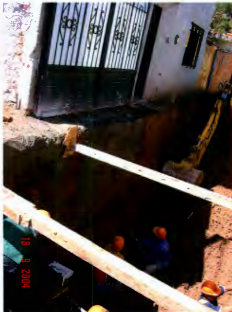
Figura 6.24 Afine de excavación en forma manual, posterior a excavación con retroexcavadora.
