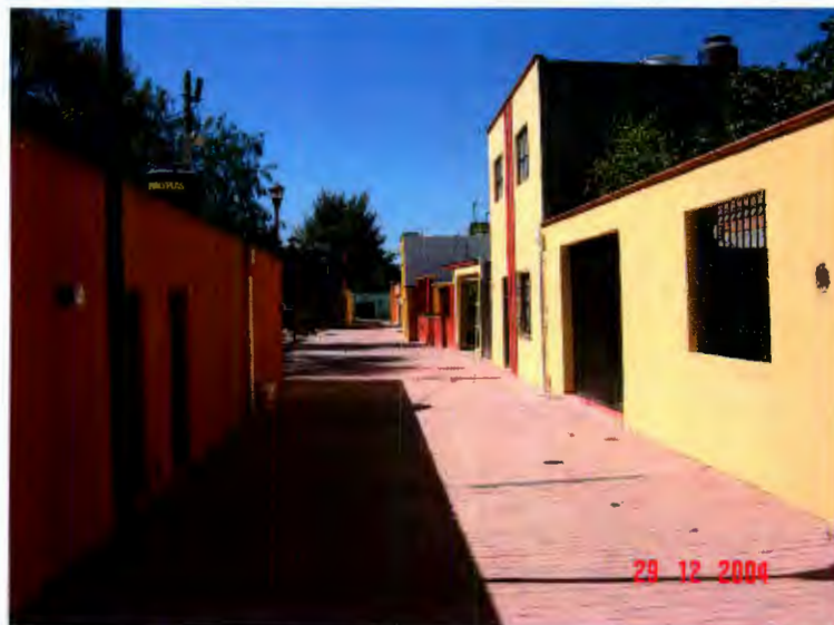
Figura 6.38 Vista de Callejón de Guadalupe con el dren terminado
