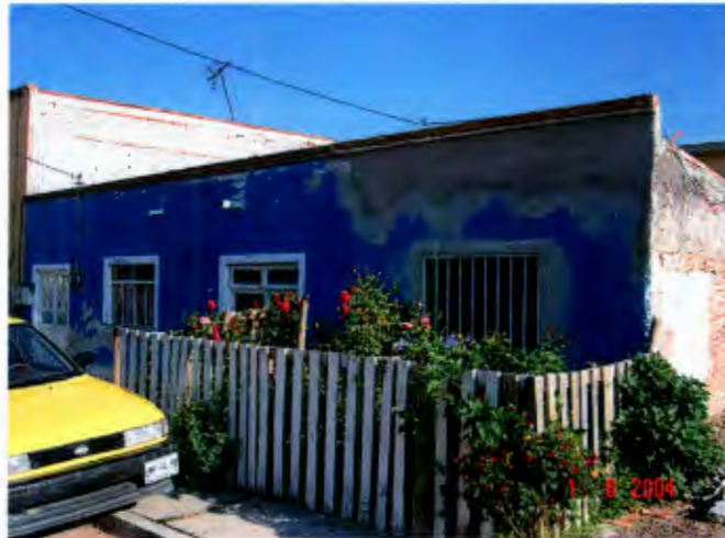
Figura 4.16 Vista de construcción en Privada de la Flor 125.
