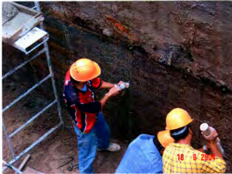
Figura 6.26 Vista de colocación y fijado de metal desplegado en talud.
