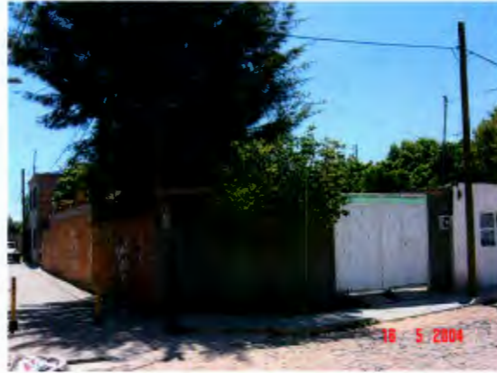
Figura 4.18 Construcción en Magdalena 138.
