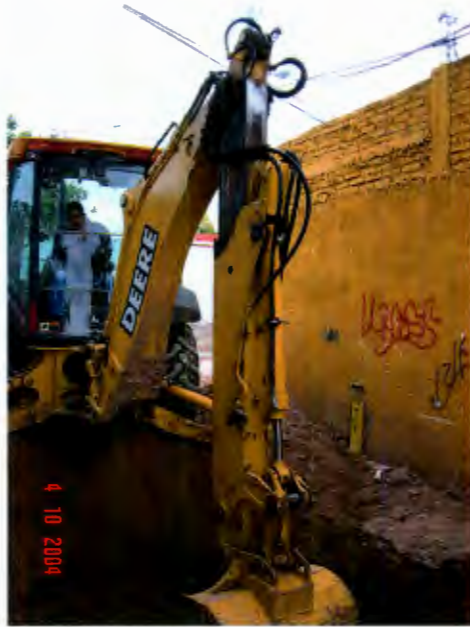
Figura 6.23 Excavación con retroexcavadora.
