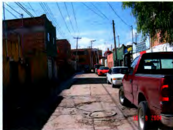
Figura 4.13 Vista de Calzada de Guadalupe.
