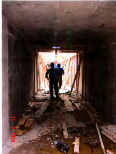
Figura 6.36 Vista interior del dren posterior al proceso de descimbrado de la losa superior.
