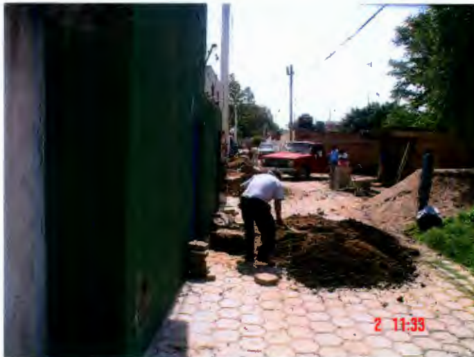
Figura 6.20 Trabajos de registros sanitarios para las nuevas instalaciones a los lados de Callejón de Guadalupe.
