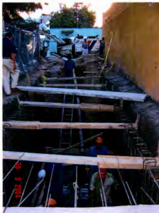
Figura 6.32 Colado de losa inferior del dren.
