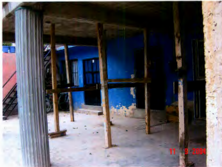
Figura 6.7 Vista de apuntalamiento losas.
