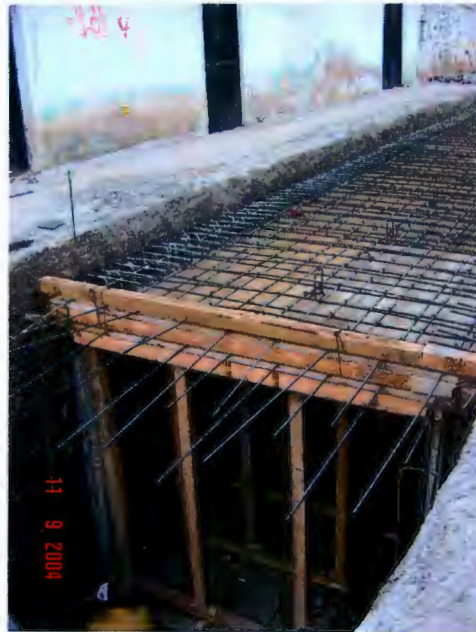
Figura 6.34 Losa superior cimbrada y armada preparada para colado.
