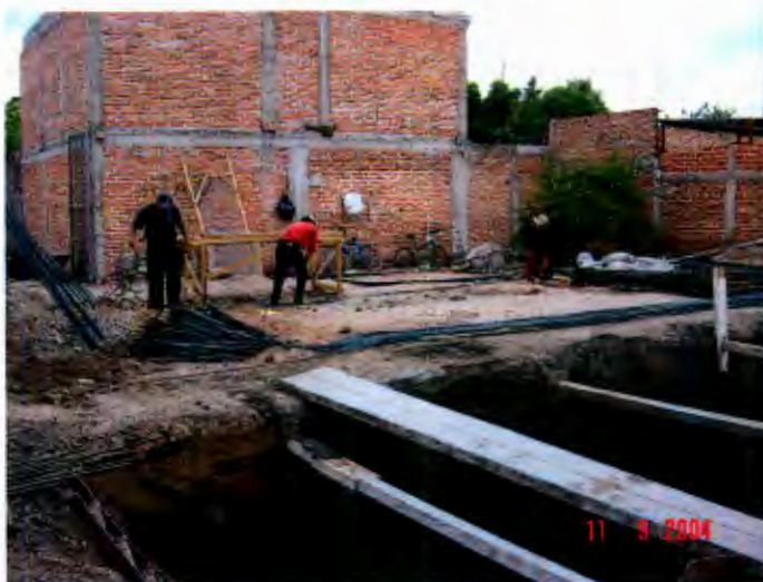
Figura 6.30 Proceso de habilitado de acero de refuerzo.
