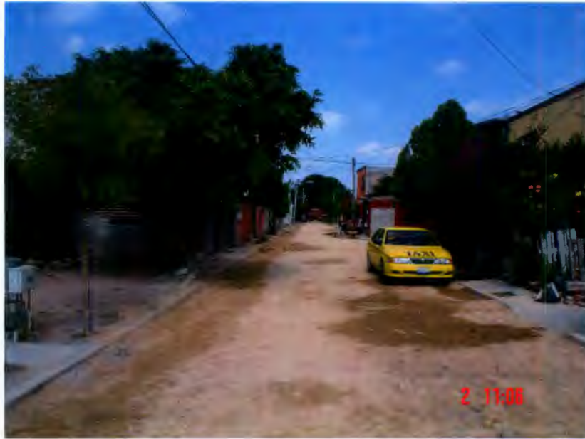
Figura 4.11 Vista general de Privada de la Flor.
