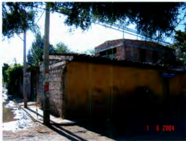
Figura 4.12 Vista de casa ubicada en calle Higuera.
