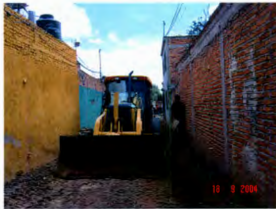
Figura 4.19 Inicio de trabajos de excavación en lindero con construcción Magdalena 138.
