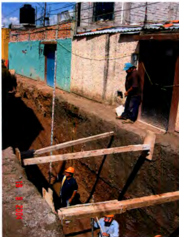
Figura 6.25 Vista de troquelado a parte superior de talud.
