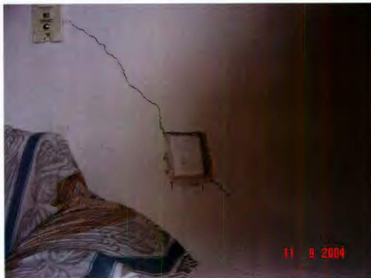
Figura 6.5 Ejemplo de testigo de yeso
