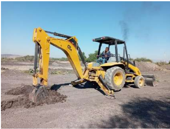
Figura 12 Excavación de pozo a cielo abierto
