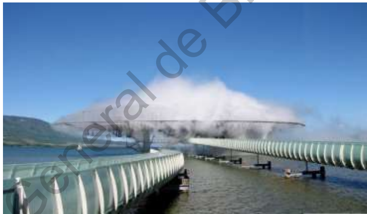
Figura 1: Edificio Blur de Diller y Scofidio. Fuente: (unbuiltarch, 2020)
