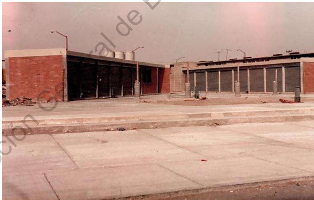
Figura 20. Locales comerciales terminados en fraccionamiento Las Armas 1987.
