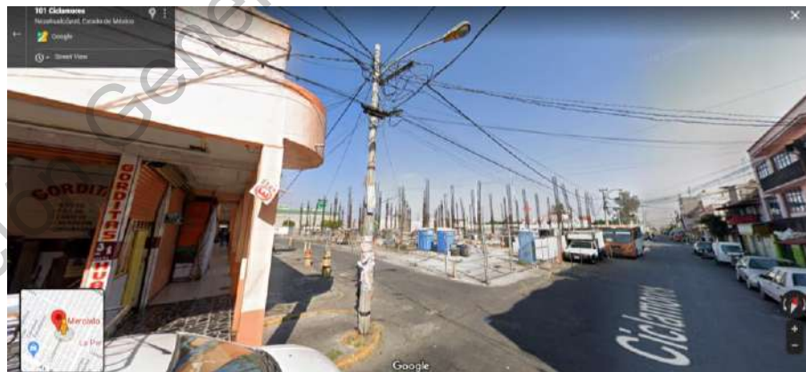
Figura 52. Vista del mercado 23 de abril y construcción abandonada en 2019.
