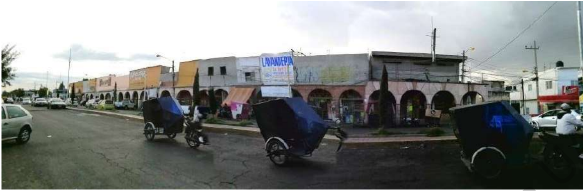
Figura 37. Construcción de segundos pisos en mercado Aureliano Ramos.
