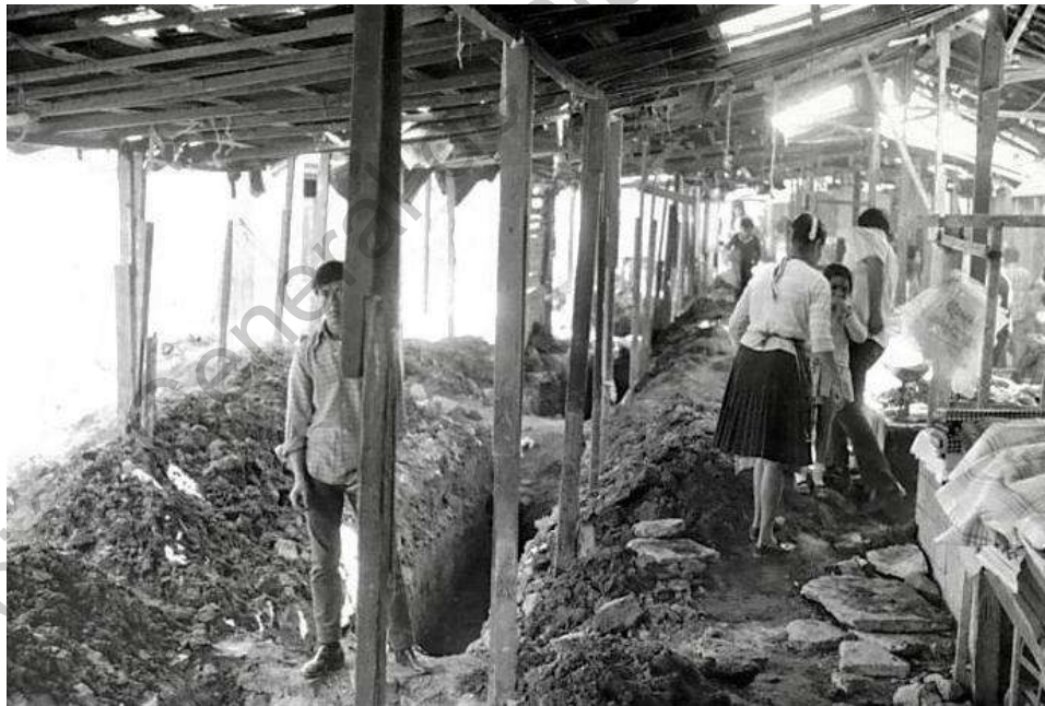
Figura 13. Ejecución de trabajos en un mercado provisional 1970.
