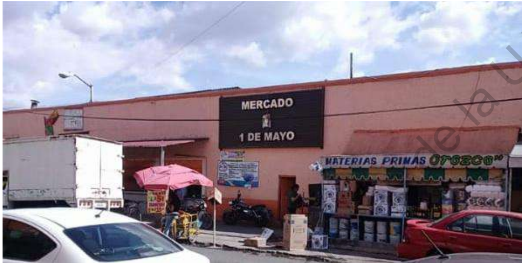
Figura 36. Fachada intervenida por el Ayuntamiento de Nezahualcóyotl.
