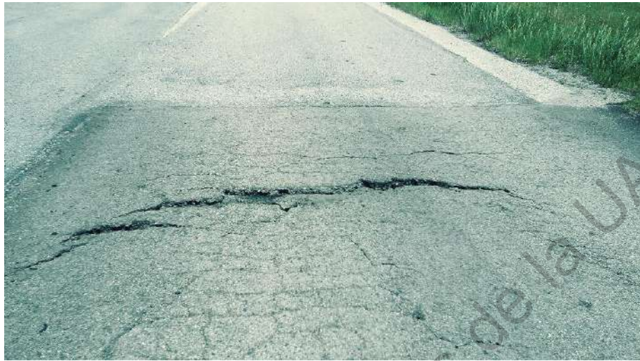
Figura 2.9 Falla por adherencia en sección de Pista de Pruebas en Centro Nacional de Tecnología del Asfalto Fuente: Elaboración propia.
