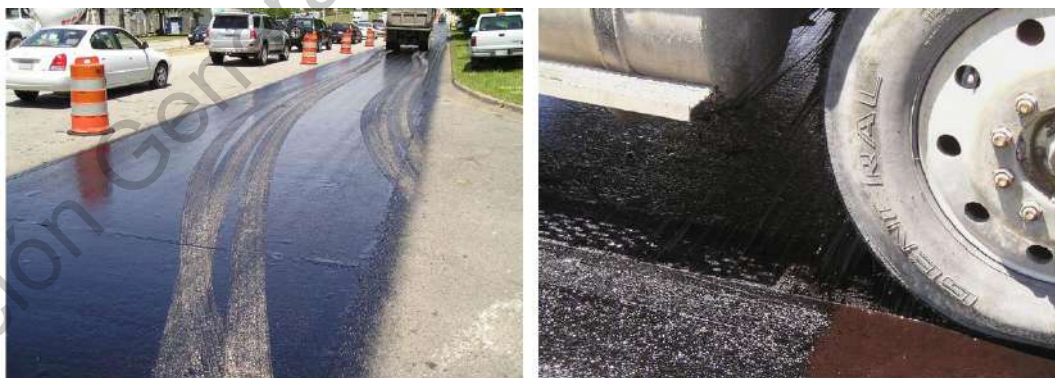
Figura 2.8 Fenómeno de desprendimiento de riego por circulación al aplicar emulsión con petrolizadora.
