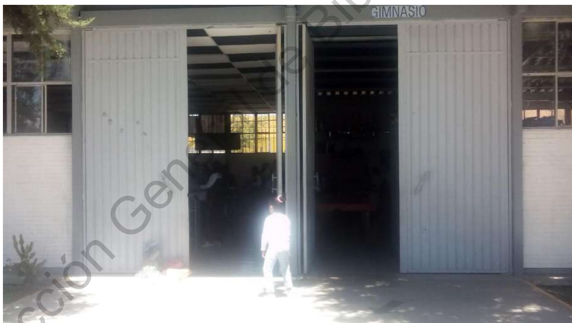
Taller de Arquitectura y Gimnasio
