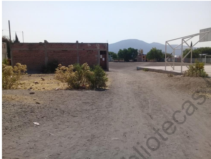
Figura 18. Casa ejidal de la comunidad de la Luz. Fotografía digital de Claudia González Ugalde. 4 de abril de 2018
