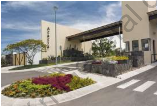
Ilustración 7 Acceso a privada del Fracc. Zibatá.
