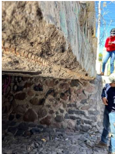
Fig. 7 “Armado de acero del puente” (Elaboración propia)
