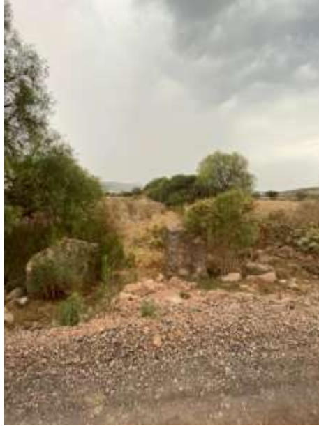
Fig. 26 “Inicio de recorrido del dren de la presa Santa Catarina” (Elaboración propia)
