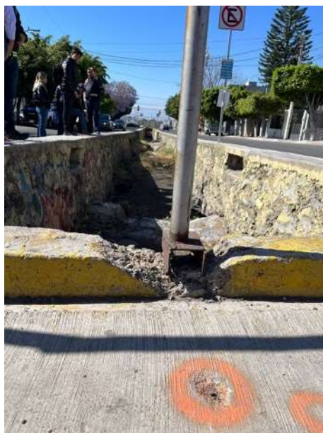
Fig. 5 “Protección del primer tramo del dren” (Elaboración propia)
