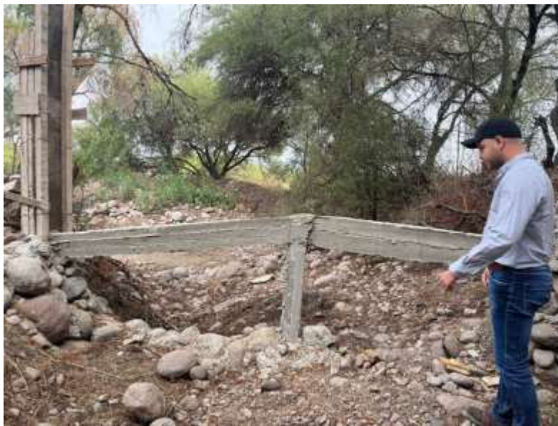
Fig. 20 “Construcción del dren” (Elaboración propia)
