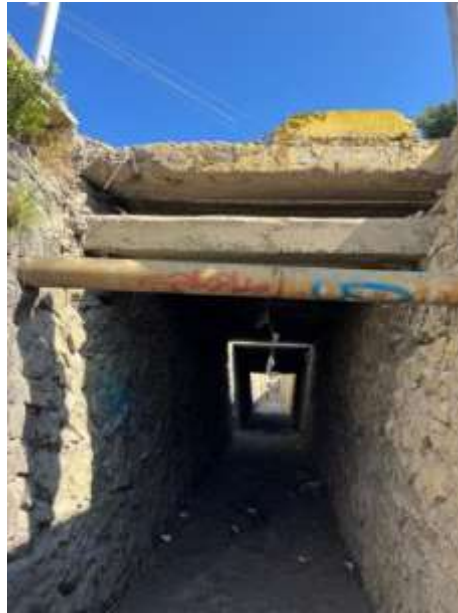
Fig. 17 “Obra de cruce” (Elaboración propia)
