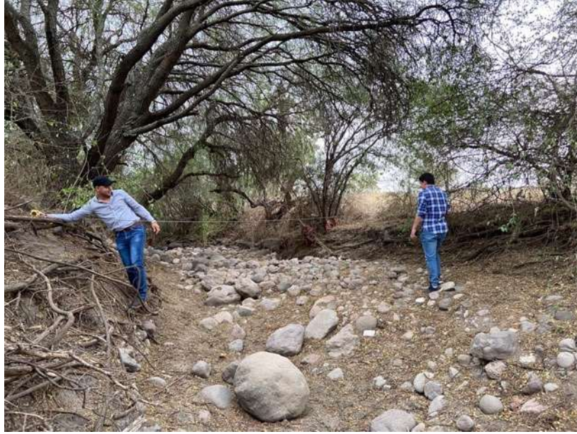
Fig. 18 “Vestimenta apropiada visita Presa Santa Catarina” (Elaboración propia)
